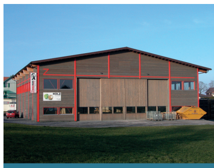
Elementbauhalle Zimmermann Holzbau und Sägerei AG
