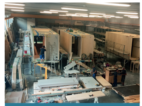
Produktion der Module in der Werkhalle
