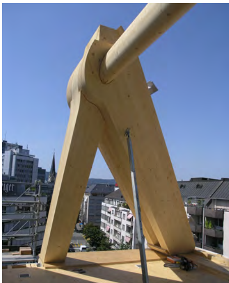
Pfosten-Zangen-Konstruktion
