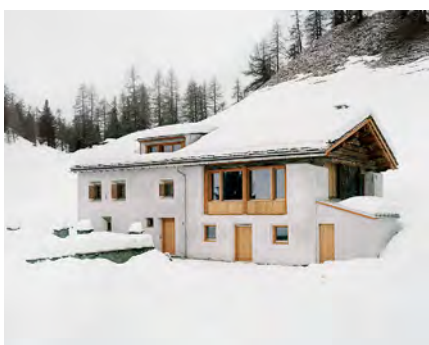
Umbau und Sanierung nachher
