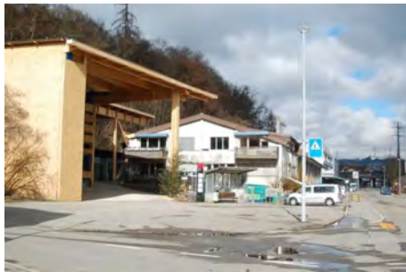
Ansicht Süd mit Provisorium
