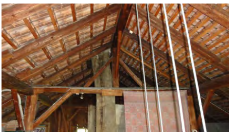
Estrich bestehende Dachkonstruktion
