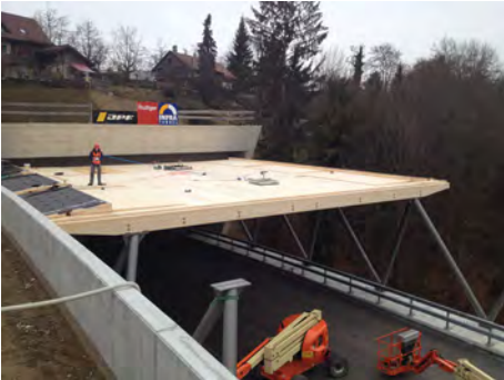
Couverture d'une partie du pont de la Poya avec 160 éléments préfabriqués, Photo Vial SA
