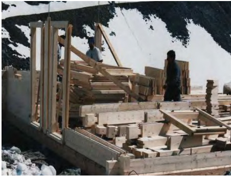
Montage d'une construction en madriers; on remarque le faible degré de préfabrication
