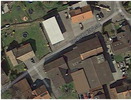
Foto Werkareal A, Gantenbein Holzbau AG
