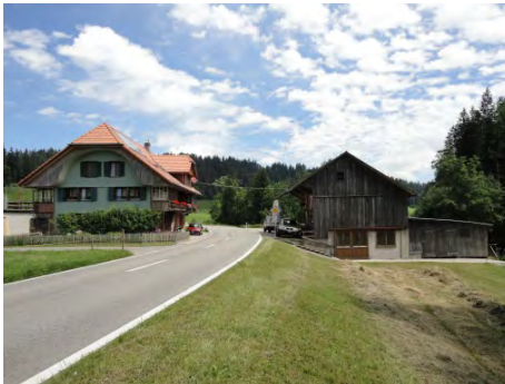
Wohnhaus und Zimmereiwerkstatt
