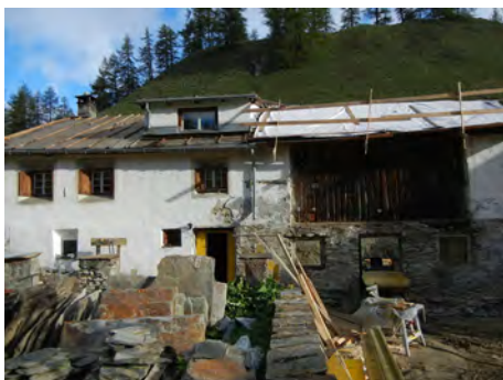
Umbau und Sanierung vorher
