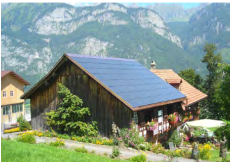
Exemple d'une toiture photovoltaïque intégrée avec des modules Megaslate
