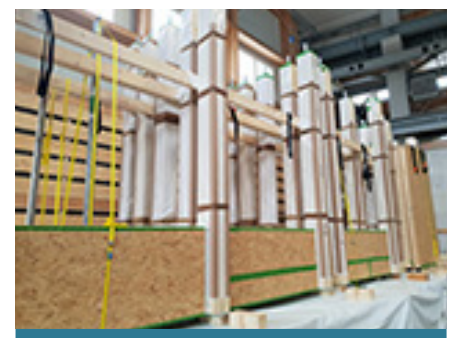
Wechselpritsche mit gefertigten Wandelementen
