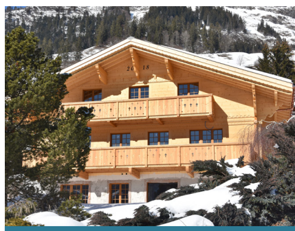
Réalisation du chalet en madrier „le Peneyсан“
