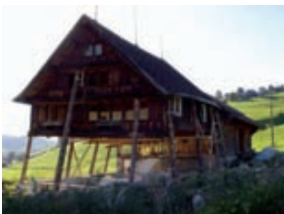
Zonenwidrig gewordenes Bauernhaus das nicht abgebrochen werden darf, Kanton St.Gallen
