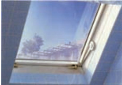
Dachfenster vor der Sanierung
