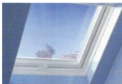
Dachfenster nach der Sanierung
