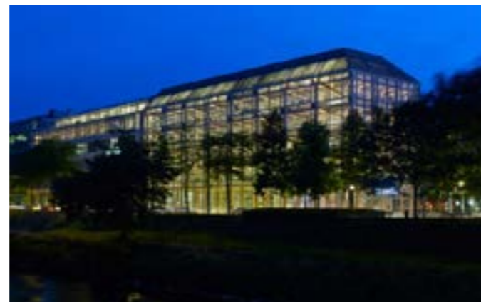
Tamedia AG Zürich; Machbarkeitsstudie energetische Effizienz und Behaglichkeit, Beratung im Bereich Bauakustik, Raumakustik, Bauphysik und Energie
