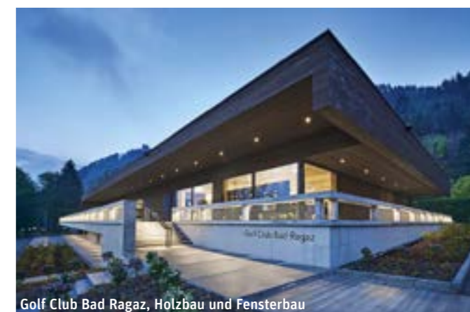
Golf Club Bad Ragaz, Holzbau und Fensterbau
