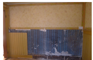
Gefügesondage: Entfernen des Täfers gibt Einsicht in darunterliegende Tapeten
