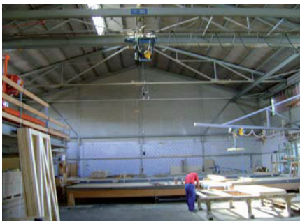
Eine der Massnahmen: isolieren der Elementhalle
