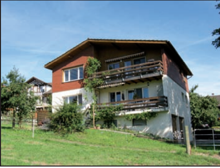
Südwestansicht des Gebäudes
