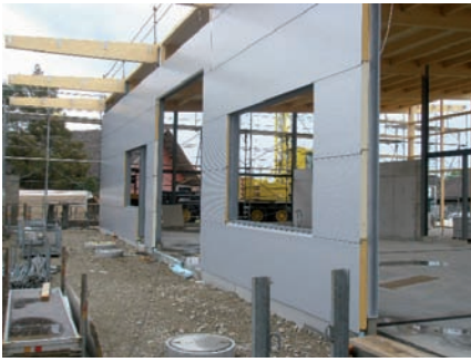
Fertig montierte Wandpaneele
