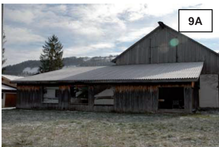
Vue Ouest (petite annexe)
