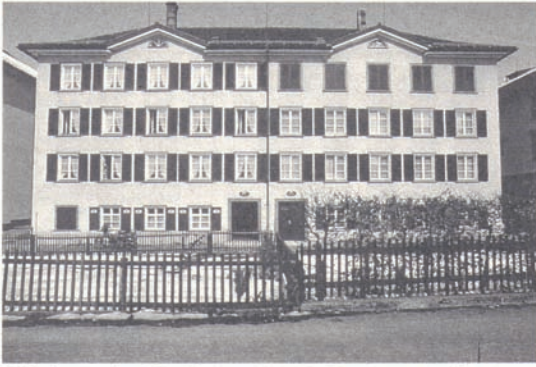
Wohnhaus eines Textilindustriellen, in Pisé-Bauweise im appenzellischen Bühler errichtet – um das Jahr 1850 erbaut.
