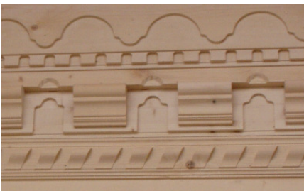
Détail de moulure de nouée
