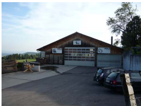
Abbundhalle mit Vorplatz Müller Holzbau (Quelle Peter Bettschen)
