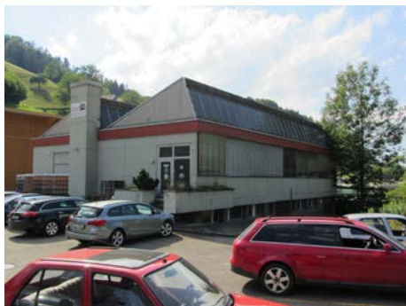
Ost- Ansicht des bestehenden Gebäudes
