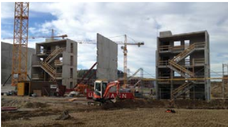
Foto Oberfeld im Rohbau (Quelle: BEER HOLZBAU AG)
