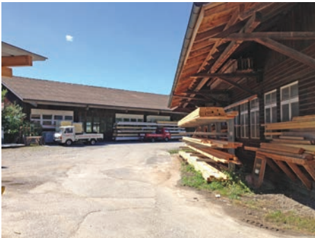
Betriebsareal Strausak Holzbau AG
