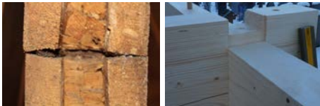
Zuamchnitt Balken/Innenwand Anschluss
