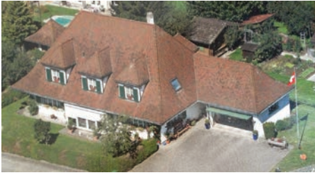
Flugbild des zu sanierenden Gebäudes
