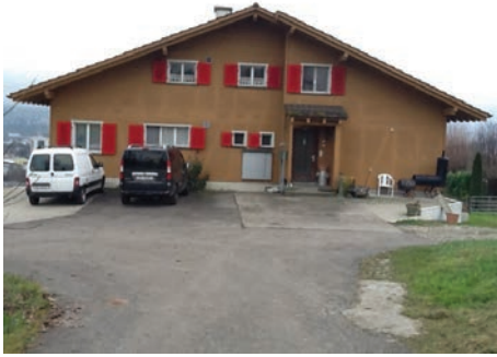
Ausgangslage, Ansicht Nordseite
