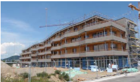
Foto Oberfeld im Rohbau (Quelle: BEER HOLZBAU AG)
