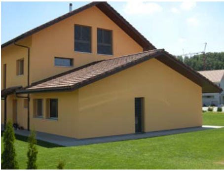
Aussenansicht des bestehenden Büros, Quelle: eigene Fotos
