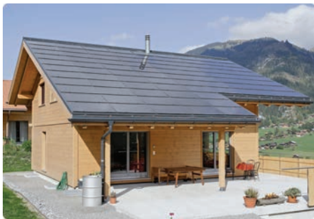
Dachintegrierte Photovoltaikanlage
