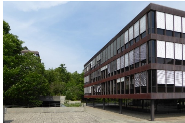
Abb. 100: Sicht von Westen auf den südlichen Aufbau (Foto: A. Rulka, 22.06.2017)
