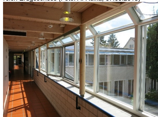
Abb. 154: Innenansicht Erschliessungs- und Aufenthaltsbereich Obergeschoss (Foto: A. Rulka, 07.09.2018)
