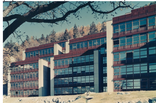
Abb. 119: Max Kasper, Kantonsschule in Chur, 1968-72 ( http://www.heimatschutz-gr.ch , Stand: Februar 2019)
