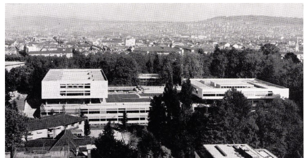
Abb. 110: Jacques Schader, Kantonsschule Freudenberg, Zürich, 1956-60, Ansicht aus der Vogelperspektive von Süden (Bauen + Wohnen, Heft 11, S. XI 1)
