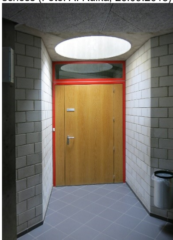
Abb. 171: Innenansicht Erschliessungszone im 2. Obergeschoss (Foto: A. Rulka, 26.09.2018)
