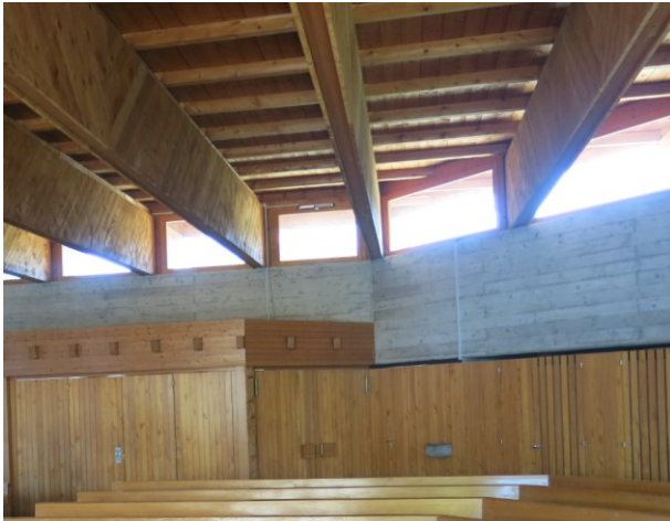
Abb. 87: Alain-G. Tschumi, Katholische Kapelle Notre Dame de la Salette, Rossemaison, 1966-69, Sicht vom Innenraum auf die Dachkonstruktion mit den in die Schicht der tragenden Binder integrierten Oberlichtbändern (Foto: A. Rulka, 26.09.2018)
