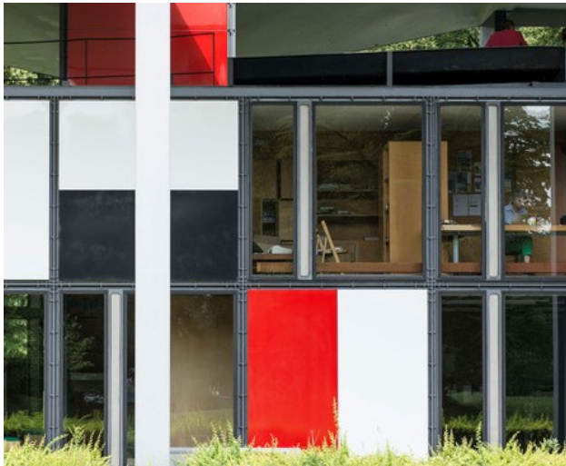
Abb. 143: Le Corbusier, La Maison d'Homme, Zürich 1965, Fassadenfragment ( https://www.myswitzerland.com/de-ch/le-corbusier-haus-heidi-weber-haus.html , Stand: Februar 2019)
