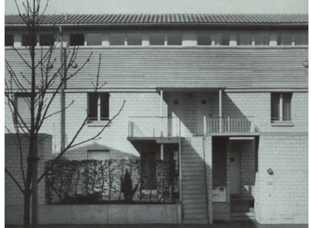
Abb. 156: Dolf Schnebli und Tobias Amman, Siedlung „Im Büel“, Baar von 1981-86, Teilansicht Eingangsfassade ( https://inspiration.detail.de , Stand: Februar 2019)
