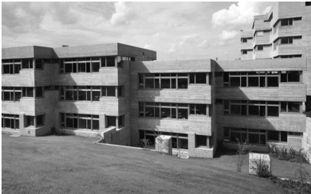
Abb. 41: Walter M. Förderer, Brunnmatt-Schulhaus in Basel, 1960-64, Südfassade des Klassentrakts (Archiv Hochbauamt Kanton Basel-Stadt)
