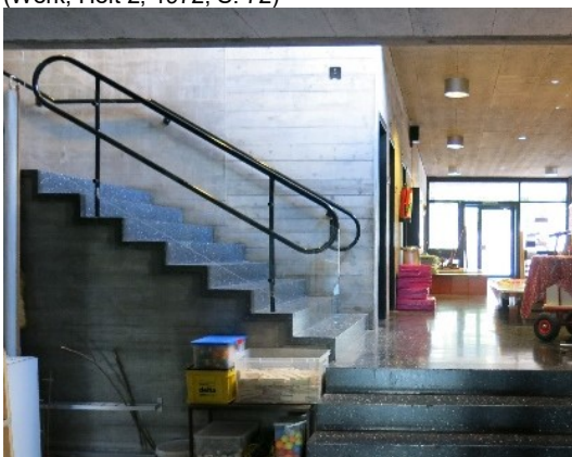
Abb. 75: Alain-G. Tschumi, Primarschule Walkermatte, Biel, 1967-68, Innentreppe mit Geländer (Foto: A. Rulka, 07.09.2018)
