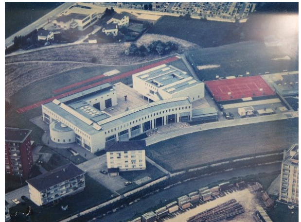
Abb. 160: Gesamtansicht aus der Vogelperspektive (Swissair Photo + Vermessungen AG, 1994)
