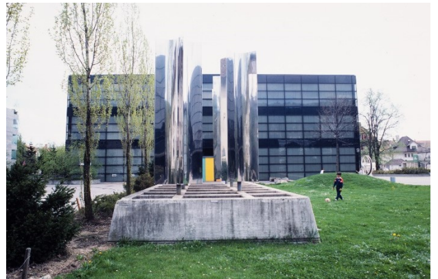
Abb. 139: Paul Talman, Plastik "Konkaver Wald" von 1975 über der Rampe zum unterirdischen Zivilschutzraum mit dem Werkstättentrakt im Hintergrund (Foto: Privatarhiv A.-G. Tschumi, undatiert)
