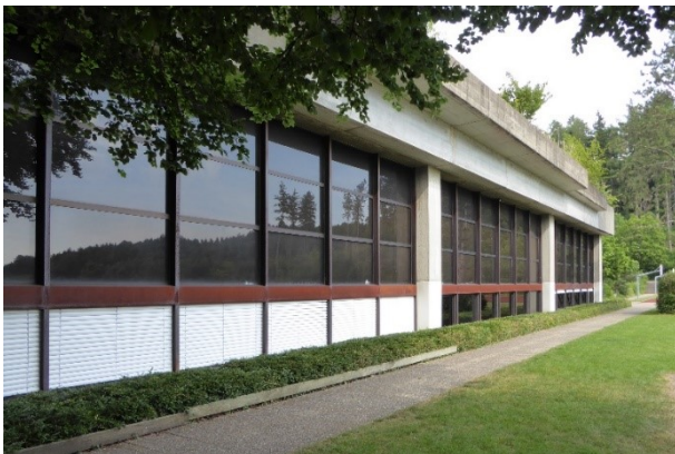
Abb. 94: Südwestfassade Turnhalle (Foto: A. Rulka, 22.06.2017)
