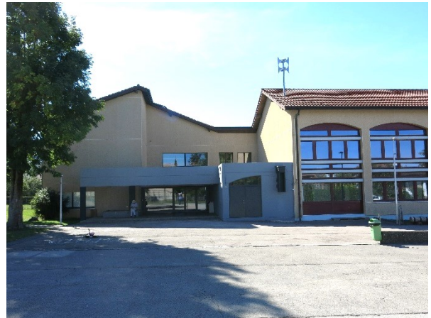
Abb. 60b: Aussenansicht von Nordwesten Richtung Eingangsbereich, heutiger Zustand (Foto: A. Rulka, 26.09.2018)
