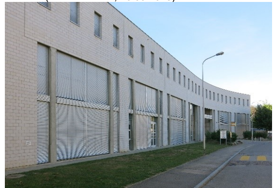
Abb. 166: Ansicht von Süden auf die geschwungene Strassenfassade des Klassentrakts (Foto: A. Rulka, 26.09.2018)
