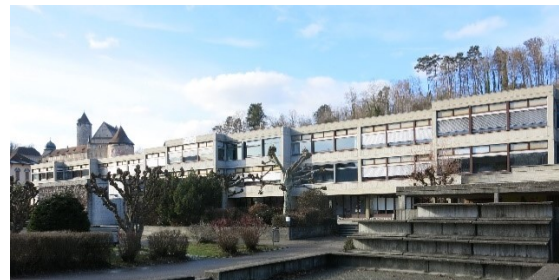
Abb. 36: Sicht von Südosten auf den Klassentrakt (Foto: A. Rulka, 18.01.2019)
