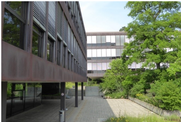
Abb. 99: Fassadenausschnitt mit den Cortenstahlelementen (Foto: A. Rulka, 22.06.2017)
