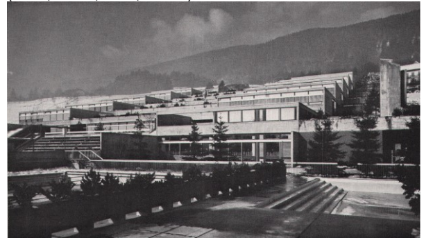
Abb. 74: Hans Dietziker, Schulhaus Halden, Grenchen, 1967-68, Gesamtansicht. (Werk, Heft 2, 1972, S. 73)
