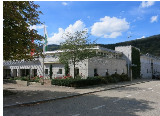
Abb. 148: Ansicht der Gesamtanlage von Südosten (Foto: A. Rulka, 07.09.2018)
