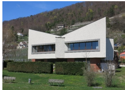
Abb. 20: Ansicht von Süden (Foto: A. Rulka, 13.04.2018)
