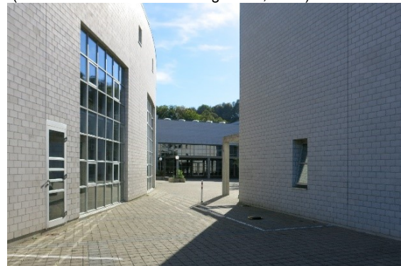
Abb. 162: Sicht von Norden zwischen dem Klassentrakt und dem Turnhallentrakt Richtung Innenhof (Foto: A. Rulka, 26.09.2018)
