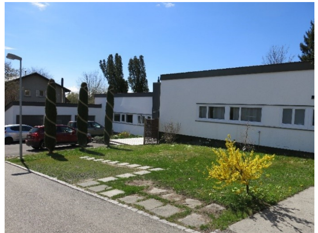
Abb. 4: Sicht von Nordosten auf die Strassenfront zweier Häuser (Foto: A. Rulka, 13.04.2018)
