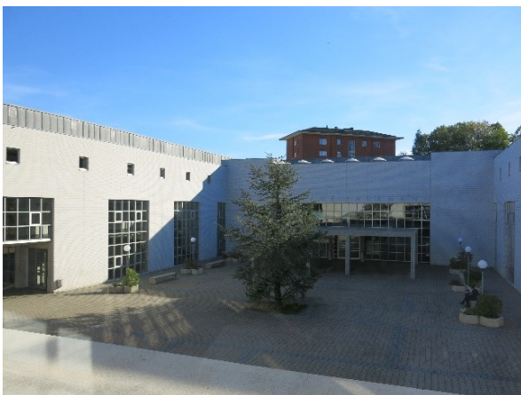
Abb. 177: Alain-G. Tschumi, Collège Thurmann, Porrentruy, 1988-93, Sicht auf den vom Klassentrakt auf drei Seiten umschlossenen Innenhof (Foto: A. Rulka, 26.09.2018)
