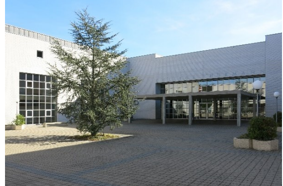
Abb. 164: Sicht vom Innenhof Richtung Haupteingang Klassentrakt (Foto: A. Rulka, 26.09.2018)
