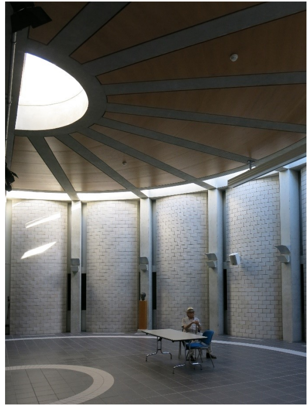
Abb. 168: Innenansicht Aula (Foto: A. Rulka, 26.09.2018)
