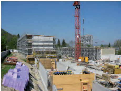
Aufrichten auf der Baustelle Grünmatt
