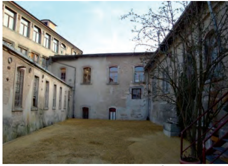
Abbildung 1, Ansicht des bestehenden Schulgebäudes von der zukünftigen Bühne aus gesehen.
