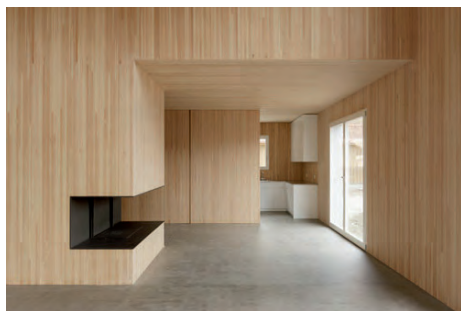
Abbildung 3: Wohnraum ausgeführt im Schuler Blockholz-System
