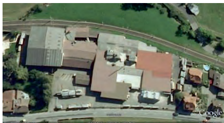
Kistenfabrik Stalden AG
