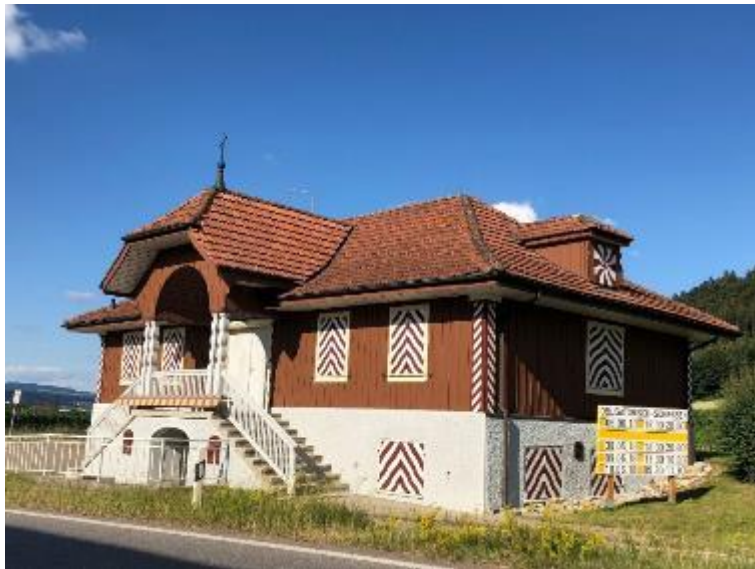
Abb. 8: Schützenhaus Ettswil, erbaut 1922 im Heimatstil. Läden in rot-weiss, den Farben des eidgenössischen Schützenverbands.
