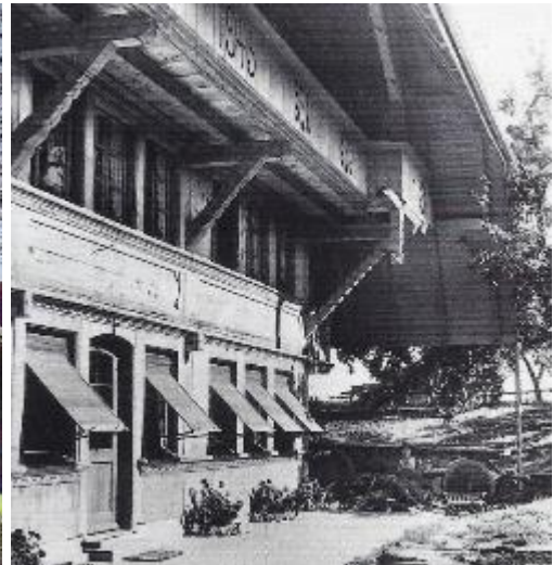
Abb. 361: Affoltern, 1945. Kuriosum, Bau im historisierenden Stil mit Reihenfenstern. Weil man trotzdem einen Schutz wollte, kamen Ausstellrollläden zum Einsatz.
