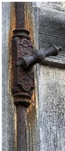
Abb. 109, 110: Griff und Führung, unten je eine Kremone (Baskülverschluss).
