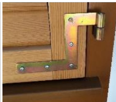
Abb. 95 bis 97: Diverse Bänder mit Kloben. Links Stützkoben mit Langband im barocken Stil, Mitte Futterkloben mit Winkelband (heute Standardband, schön ausgemittelt auf dem Rahmenfries), rechts Aluladen mit verstellbarem Band.
