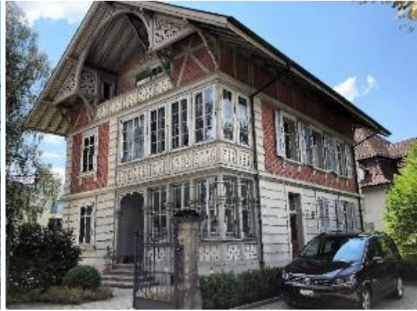
Abb. 208: Wohnhaus, Langenthal, 1899. Historisierend, gemischte Konstruktion mit Sichtbackstein und Dekor im Schweizerhaus-Stil.
