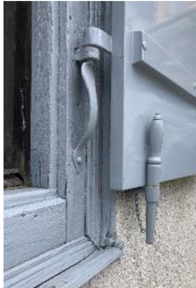
Abb. 116 bis 118: Links Vorreiber geschmiedet, Mitte Holzsetzholz, rechts Metallstift verkettelt.
