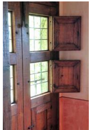
Abb. 28: Innenladen wie im Mittelalter gebräuchlich.
