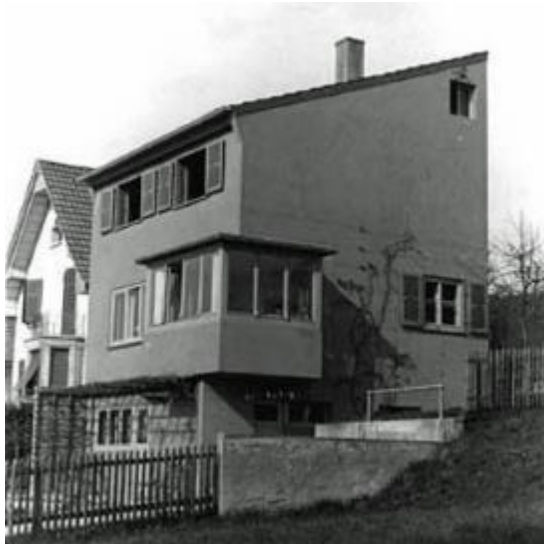
Abb. 241: Haus Schibli, Lengnau BE, Architekt E. Lanz, 1927. Das Haus war zur Bauzeit avantgardistisch mit dem Pultdach, fast ohne Vordach und dem klaren, kubischen Erker. Auch bei den Läden mit festen Lamellen und quadratischen Feldern wurde die Moderne betont.
