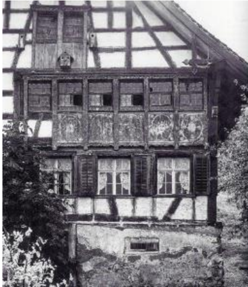
Abb. 301: Bauernhaus Tobel, Bild von 1911. EG neue Kreuzstöcke mit Klappläden, OG Reihenfenster mit Zugläden und Malereien.
