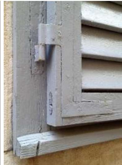
Abb. 54: Laden mit beweglichen Lamellen, mit durchgehenden Zapfen verkeilt.
