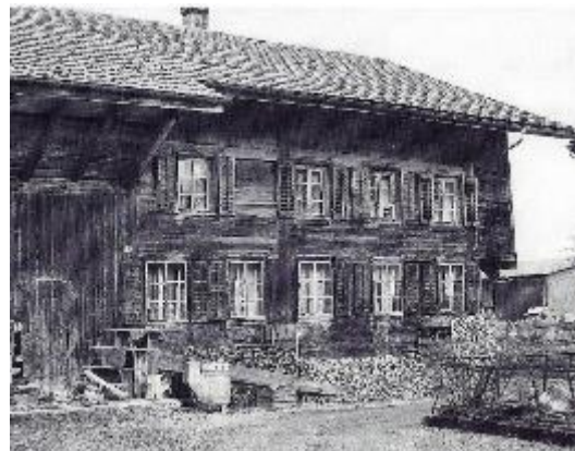
Abb. 322: Auw, 1723. Tätschhaus mit Einzelfenstern, beidseitigen Läden mit beweglichen Brettli.
