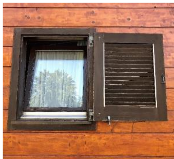
Abb. 79: Chalet, Fischbach LU, feste Lamellen zurückstehend. In den 1970er-, 1980er-Jahren wurde manchmal anstelle der Fräsungen im Fries eine entsprechende Aluleiste eingesetzt, was eine einfachere maschinelle Einrichtung des Jalousiebauer erlaubte.
