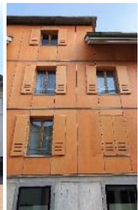
Abb. 254, 255: Geschäfts- und Wohnhaus, Willisau, 1999. Läden in bakelisiertem Sperrholz.
