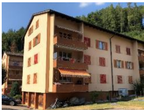
Abb. 251: Mehrfamilienhaussiedlung, Willisau. 1960er-Jahre, typisch in dieser Zeit bei kleineren Überbauungen sind die Holzläden.
