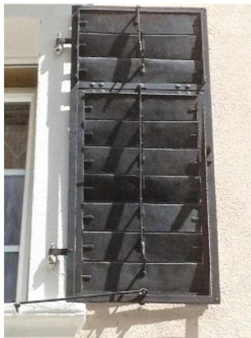
Abb. 199: Sogar Läden mit beweglichen Lamellen und Ausstellrahmen gibt es in Stahl. Als Rückhalter Sperrstange.
