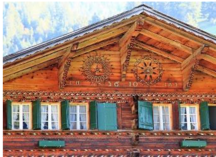
Abb. 354: Chalet Grodey/St. Stephan, 1610. Mit nachträglichen Fensterläden, welche offen 90° zur Fassade stehen.
