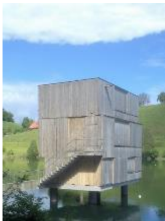
Abb. 266, 267: Ziel-Turm Ruderzentrum, Rotsee LU, 2013. Läden in Dreischicht-Massivholzplatten, kombiniert mit Stahl.
