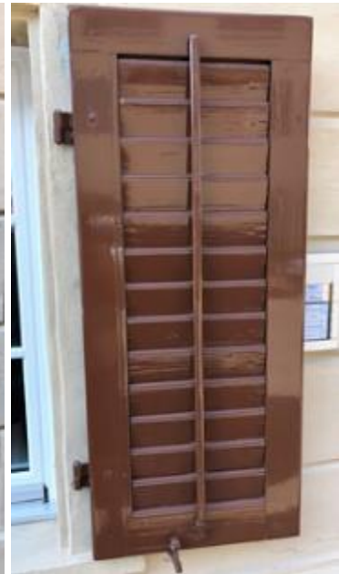
Abb. 86, 87: Deutlich sichtbar die Veränderung der Proportionen der Läden. Links mit schmalen Rahmen und breiten Brettli, ca. Anfangs 20. Jh.. Rechts breiter Rahmen und schmale Brettli, ca. 1950/60er-Jahre. Links ohne Brettlisteller, rechts mit Holzriegel als Brettlisteller.
