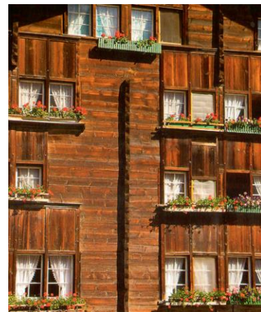
Abb. 298: Wohnhaus in Elm im Strickbau mit Fallläden.
