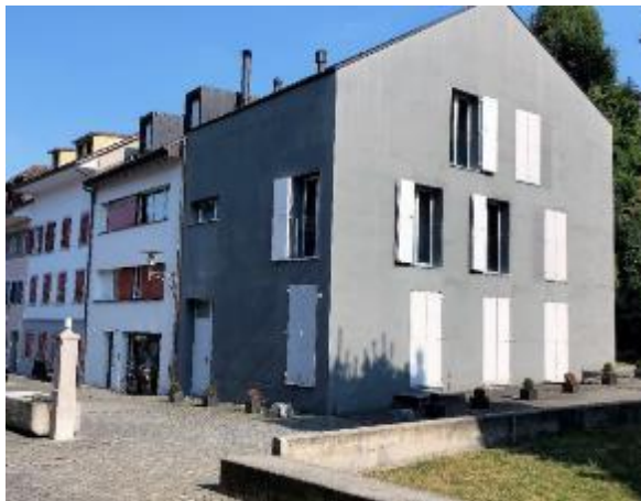
Abb. 269: Wohnhaus, Hintergasse, Willisau, 2002. Drehflügelläden in Alu, flaches Blech.
