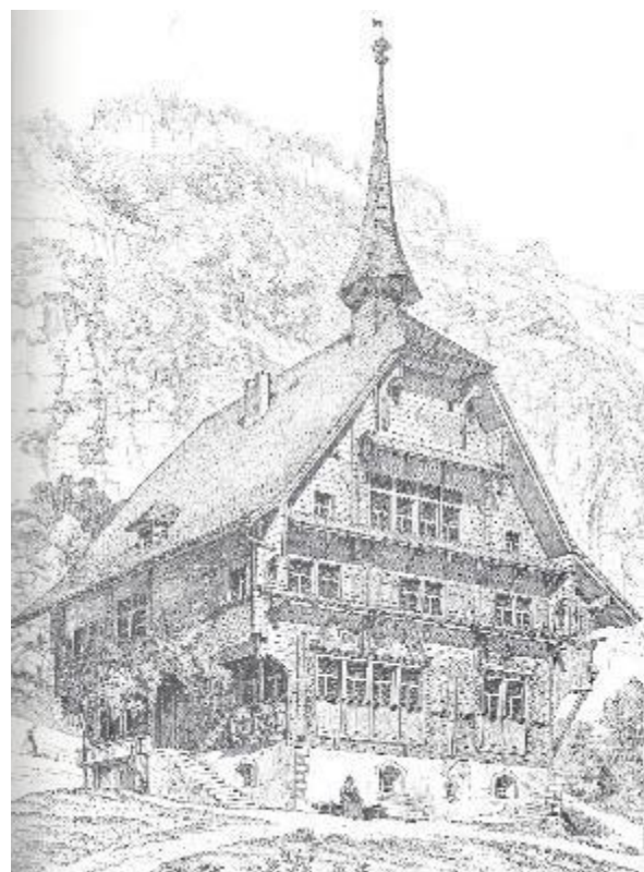
Abb. 342: «Hechhuis», Wolfenschiessen, 1586. Unter dem Gehrschild links und rechts und beidseits neben dem obersten Klebedach sind Heiterlöcher zu sehen.
