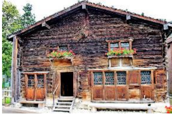
Abb. 295: Zustand heute, mit grossen Fenstern und alle Fenster mit komfortablen Zug- oder Schiebläden.
