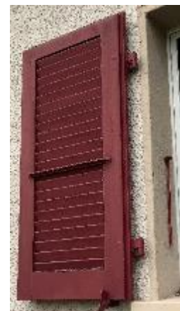
Abb. 107, 108: Rechen mit Sperrstange in der Leibung (Berner Rechen).
