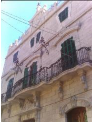
Abb. 215: Jugendstilfassade in Soller, Mallorca. Fensterläden in Rahmenbauweise mit festen Lamellen, dem Fenster angepasst.
