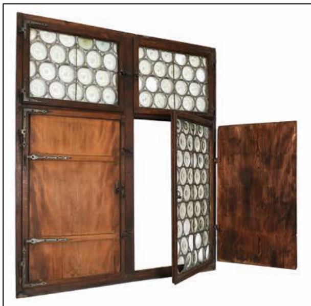
Abb. 168: Barockes Kreuzstockfenster mit gerateten Innenläden. Beschläge: Stützkloben mit Langbänder, als Verschluss Vorreiber.
