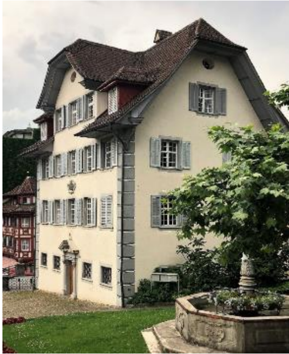
Abb. 176: Peyerscher Chorhof im Stiftsbezirk Hof, Luzern, 1695. Läden mit beweglichen Brettli nicht aus der Bauzeit, Läden in der Bauzeit waren wie Abb.177 oder 178.
