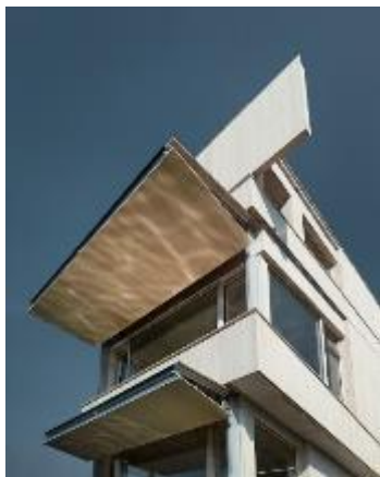
Abb. 266, 267: Ziel-Turm Ruderzentrum, Rotsee LU, 2013. Läden in Dreischicht-Massivholzplatten, kombiniert mit Stahl.
