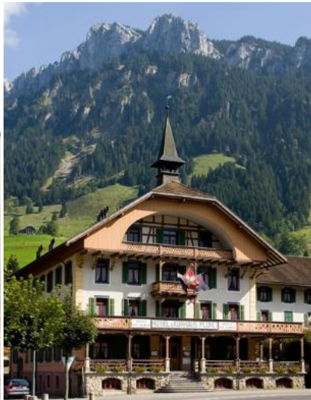
Abb. 210: Kurhaus Flüeli, 1900. Bauzeuge der Blütezeit der Berghotellerie. Läden zweifeldrig mit beweglichen Lamellen.
