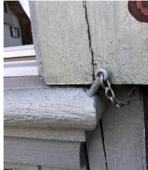
Abb. 116 bis 118: Links Vorreiber geschmiedet, Mitte Holzsetzholz, rechts Metallstift verkettelt.
