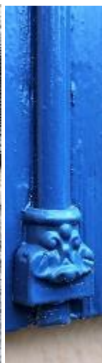
Abb. 109, 110: Griff und Führung, unten je eine Kremone (Baskülverschluss).
