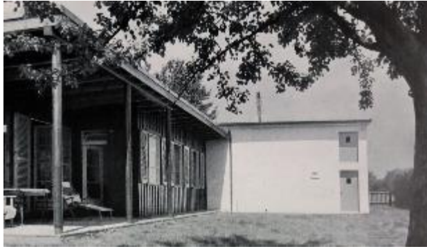
Abb. 245: Haus mit Atelier in Riehen, 1935, Architekt Paul Artaria. Holzbau mit Drehläden links und rechts. Gemauertes Atelier mit Metallfenster ohne Sonnenschutz (auf diesem Foto nicht sichtbar).
