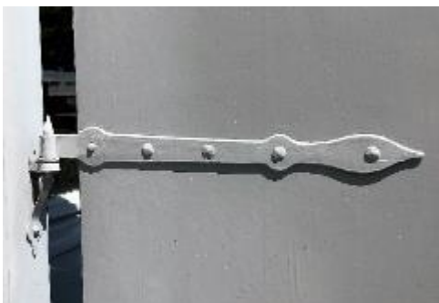
Abb. 95 bis 97: Diverse Bänder mit Kloben. Links Stützkoben mit Langband im barocken Stil, Mitte Futterkloben mit Winkelband (heute Standardband, schön ausgemittelt auf dem Rahmenfries), rechts Aluladen mit verstellbarem Band.
