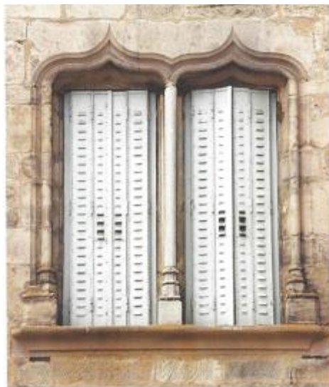
Abb. 26, 27: Spalettläden, Faltklappläden oder Persienne. Bild links Ausführung in Holz im offenen Zustand. Laden kann in der Leibung versorgt werden. Bild Mitte Ausführung in Metall im geschlossenen Zustand.
