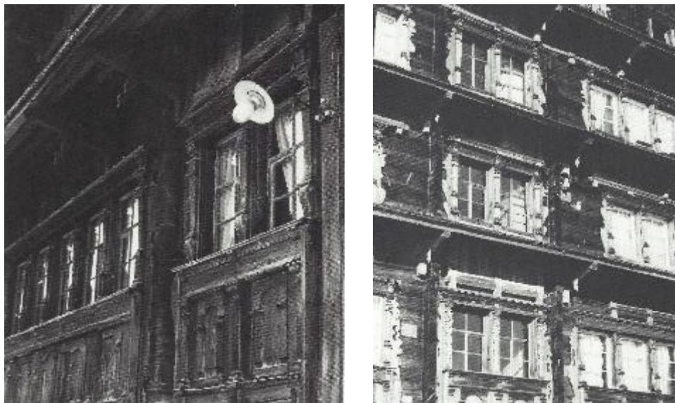
Abb. 287, 288: Zwei schöne Fassaden mit Renaissance-Zugläden. Links Hofstetten 1684, mit gleichmässig gealterter Fassade. Rechts ein anderes Haus in Hofstetten von 1680, die Verkleidungen wurden nach altem Vorbild erneuert und sind darum noch heller.
