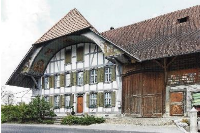
Abb. 358: Herzogenbuchsee/Oberönz, 1790. Riegelbau, Quergiebel. Kreuzstockfenster mit Stichbogen und den stilgemässen, festen gegarteten Läden.
