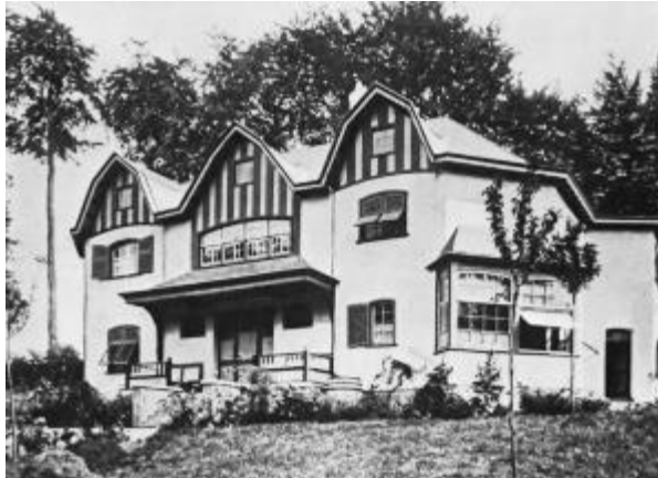
Abb. 211: Villa Bloemenwerf, Wohnhaus von Henry Van de Velde, 1896. Fensterläden mit festen Lamellen, unteres Feld mit Ausstellrahmen.
