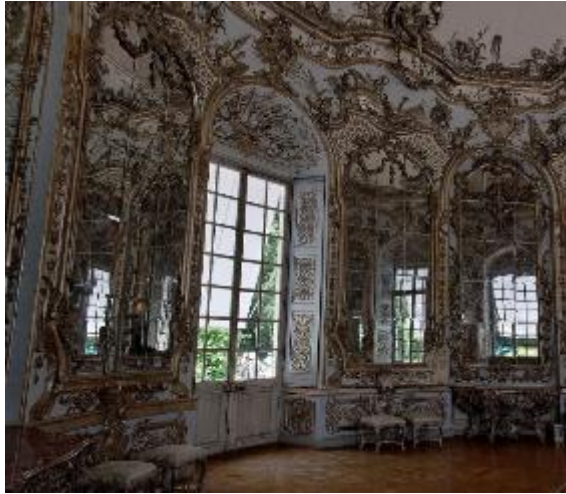
Abb. 169: Amalienburg, Schlosspark Nymphenburg, München, 1734 bis 1739. Spiegelsaal, aufwendige Läden, in die Leibung integriert. Ornamentik und Stuck werden in den Läden übernommen.
