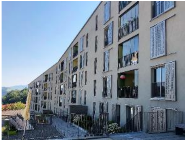
Abb. 264, 265: Genossenschaftliches Wohnen, Luzern. Links Teil Neubau, 36 Wohnungen mit Aluschiebeläden. Rechts renovierte Mehrfamilienhäuser mit 98 Wohnungen in unmittelbarer Nähe, aus den 1940er- und 1950er-Jahren. Die alten Holzläden wurden durch Aluläden mit gleichem Design wie im Neubau ersetzt.
