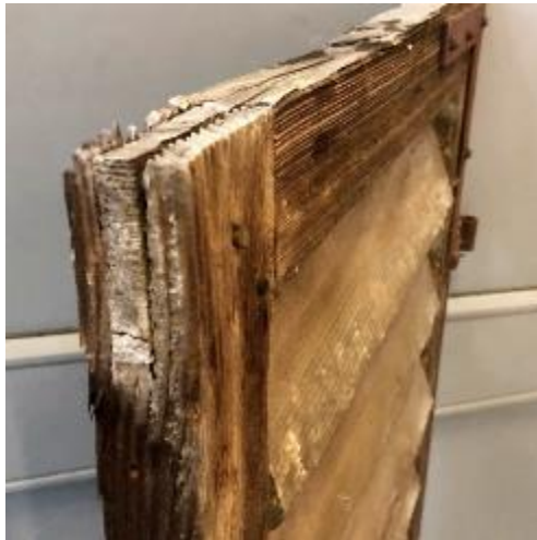
Abb. 51: Laden aus der zweiten Hälfte des 19. Jh. (Zeit geschätzt). Die Ecken sind nicht verleimt, sondern nur mit Holznägeln fixiert.
