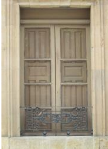
Abb. 65: Innenläden gestemmt, mit div. abgeplatteten Füllungen.
