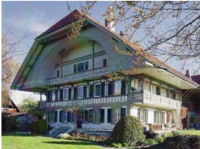
Abb. 360: Iffwil, 1911. Bauernhaus im Heimatstil, Läden mit beweglichen Brettli.
