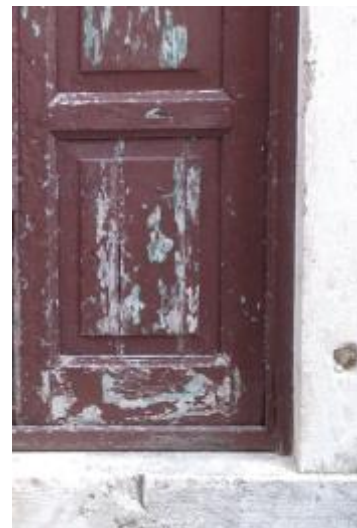
Abb. 56: Ladendetail, gestemmt mit Beizapfen auf Gehrung.
