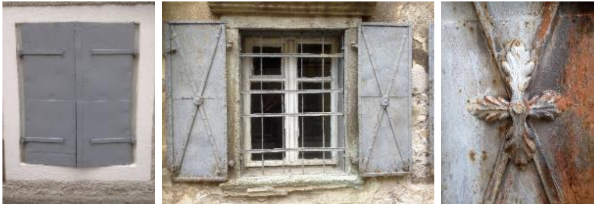
Abb. 195 bis 197: Trzic, Slowenien, eiserne Läden. Die häufigste Ausführungsart war mit Stahlblech auf der Bandseite, auf der gegenüberliegenden Seite Flachstahl als Verstärkung und Andreaskreuz, meistens mit Zierrosette als Dekor.
