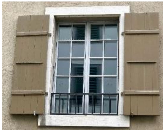
Abb. 107, 108: Rechen mit Sperrstange in der Leibung (Berner Rechen).
