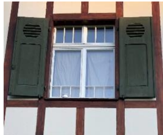
Abb. 69: Kombination von Füllungen und Lamellen. Profil bei den Füllungen wurde ein- und ausgefahren.
