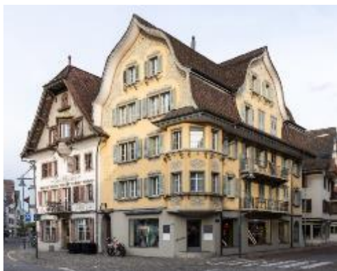
Abb. 227: Dorfplatz 12, Sarnen, 1925. Nach Dorfbrand von Architekt Robert Omlin neu erstellt, Heimatstil (Neobarock). Fensterläden mit beweglichen Lamellen, Erker mit Rollläden.
