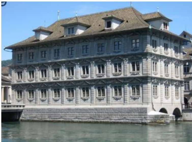
Abb. 154: Rathaus Zürich, 1694 bis 1698, Spätrenaissance mit klar gestalteter Fassade und regelmässigen Fenstern ohne Fensterläden.
