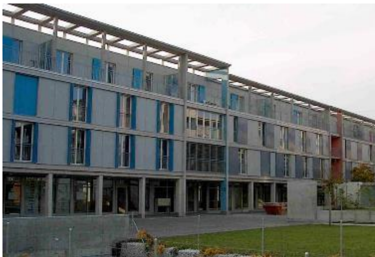
Abb. 262: Färbi-Areal Zofingen, 2000. Die Läden der Überbauung haben drei verschiedene Öffnungsarten, Falt-, Schiebe- und Klapp-läden. Schiebeläden aus Multiplex deckend gestrichen.
