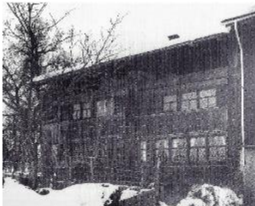
Abb. 321: Tätschhaus mit ursprünglicher Fassade, Reihenfenster und Fallläden. Foto um 1900.
