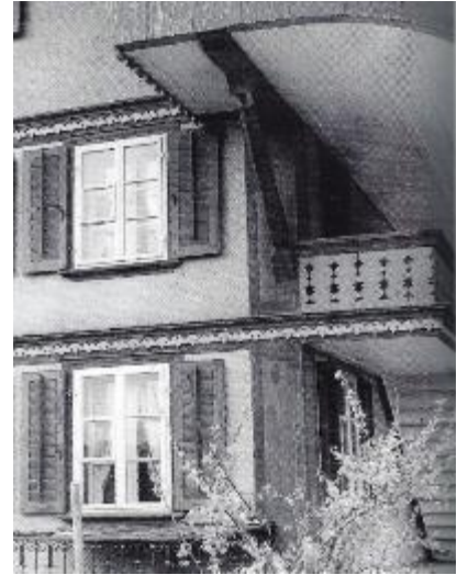
Abb. 359: Lützelflüh, 1872. Schweizerhausstil mit Dekorelementen, Rundschindeln, Verzierungsprofilen und Fensterläden mit beweglichen Brettli.
