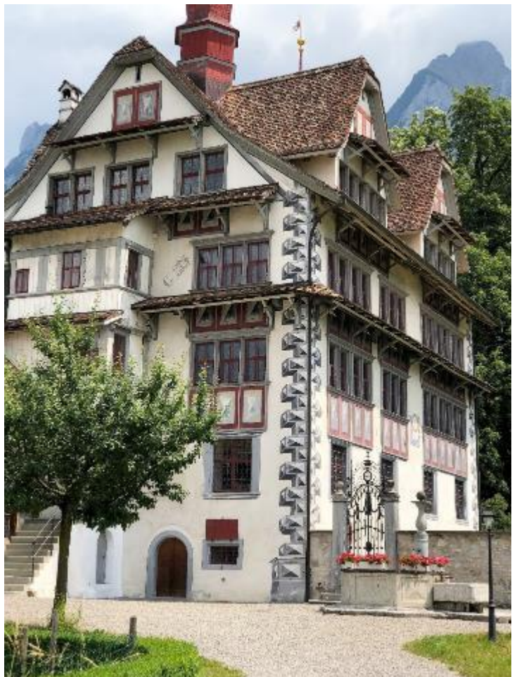
Abb. 167: Ital Reding Haus, 1609. Schiebeläden und dreidimensional bemalte Verkleidungen.
