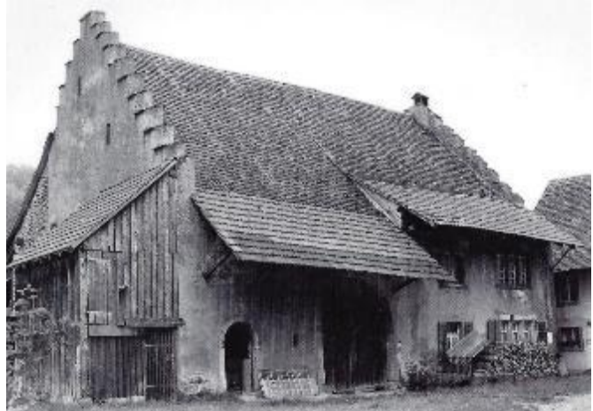
Abb. 324: Villnachern, 1591/1690. OG mit originalen gotischen Fenstern. Im EG hinter Holzstapel Fenster aus dem 19. Jh. mit Läden.
