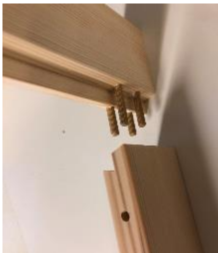
Abb. 62: Unverleimte obere rechte Ecke eines Ladens mit beweglichen Brettli, auf Contrefaçon mit vier Dübeln.
