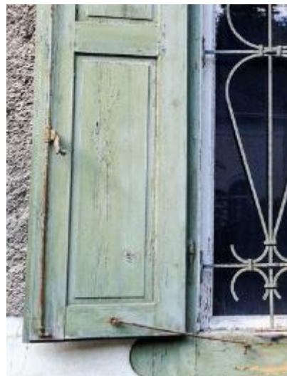
Abb. 57: Ladendetail, gestemmt mit Beizapfen auf Contrefacon.
