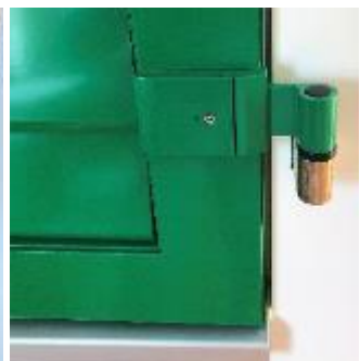
Abb. 95 bis 97: Diverse Bänder mit Kloben. Links Stützkoben mit Langband im barocken Stil, Mitte Futterkloben mit Winkelband (heute Standardband, schön ausgemittelt auf dem Rahmenfries), rechts Aluladen mit verstellbarem Band.
