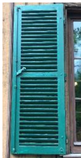
Abb. 112, 113: Zwei verschiedene Espagnoletten. Links aus zweiter Hälfte 19. Jahrhundert, rechts aus erster Hälfte 20. Jahrhundert.
