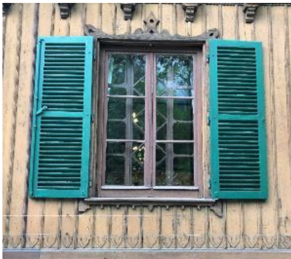
Abb. 209: Fabrikantenvilla im Schweizerhaus-Stil, Ballenberg, ursprünglich Burgdorf. Fensterläden mit festen, bündigen Lamellen mit Espagnolette.
