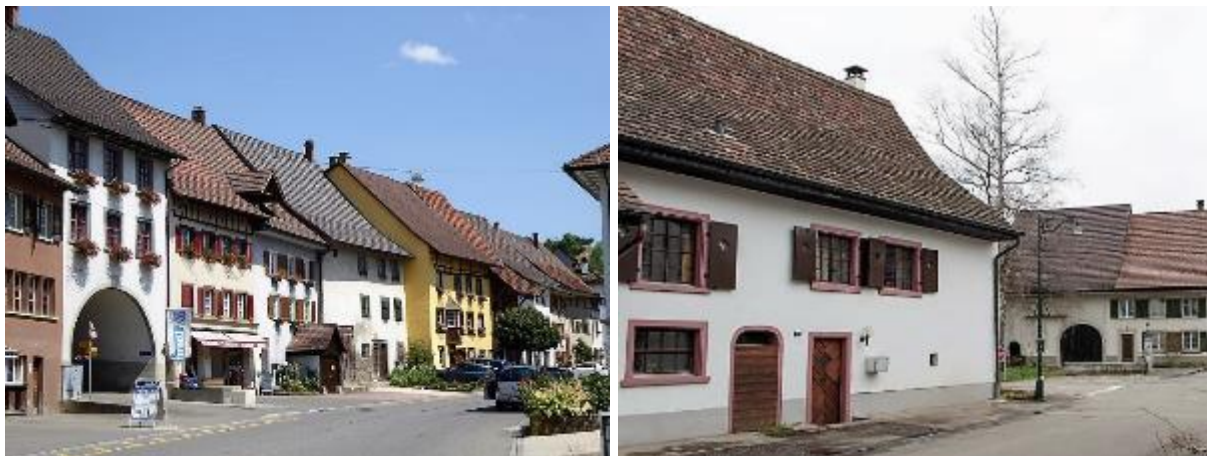
Abb. 314, 315: Links Rebbaudorf Wilchingen SH. Rechts Arisdorf BL mit Kleinbauernhäusern. Beide Fotos mit Einzelbefensterung mit seitlichen Schlagläden oder auch ohne Läden.
