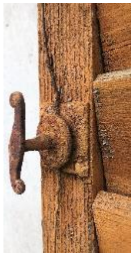
Abb. 111: Kremone betätigt über Drähte die Schliesser.
