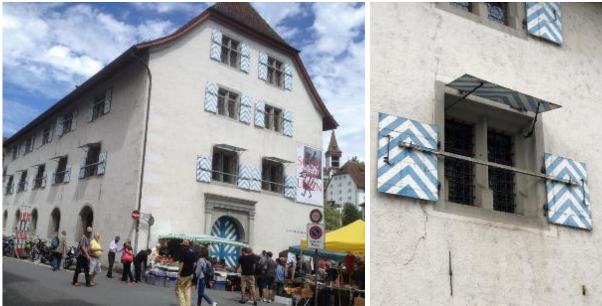
Abb. 146, 147: Historisches Museum Luzern, ehemaliges Zeughaus, 1567. Die Fenster sind noch gotisch gestaltet, mit eisernen Fensterläden, im ersten Stock eine kombinierte Öffnungsart, unten seitliche Drehläden, oben Klappläden.
