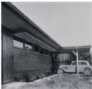
Abb. 243, 244: Sommerhaus am Untersee, 1937, Architekt Alfred Roth. Man beachte den Gegensatz zwischen der futuristischen Architektur und dem Automobil. Modern gestaltete Läden mit akzentuierten Lüftungsschlitzen, die immer nach der längeren Seite des Ladens ausgerichtet sind. Die Oblichtfenster sind mit Klappläden ausgerüstet.
