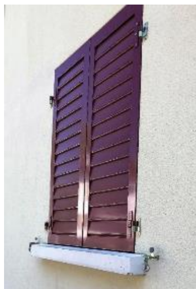
Abb. 257: Sanierung einer Überbauung aus den 1950er-Jahren mit Aluläden.
