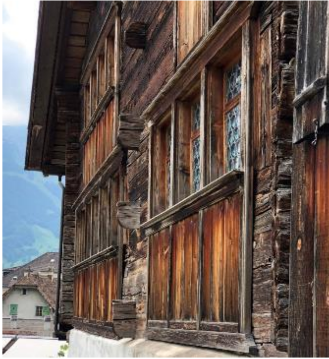
Abb. 180, 181: Haus Bethlehem, Schwyz, 1287. Fenstergestaltung nach einem Umbau im 18. Jh. mit Schiebeläden und Klappläden, unbehandelt. Die Zugladenkästen wurden 1989 nach Vorbild rekonstruiert.
