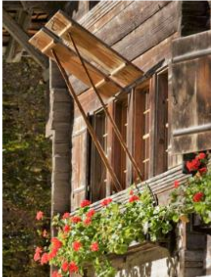
Abb. 114: Matten BE, 1570. Im Freilicht-Museum Ballenberg. Klapppläden mit Spritli (Latte) gehalten.
