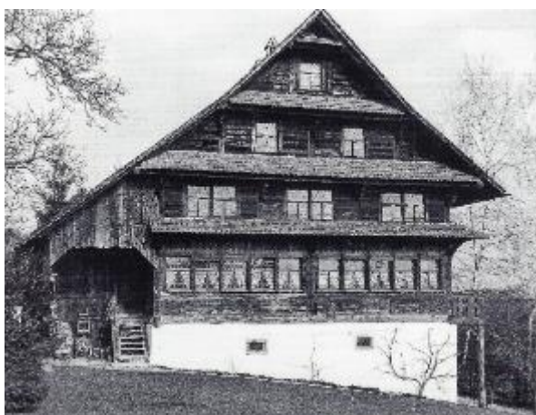
Abb. 329: Geltwil, um 1800. Bauernhaus mit Reihenfenstern und Fallläden im EG und Zwillingsfenster ohne Läden im OG.
