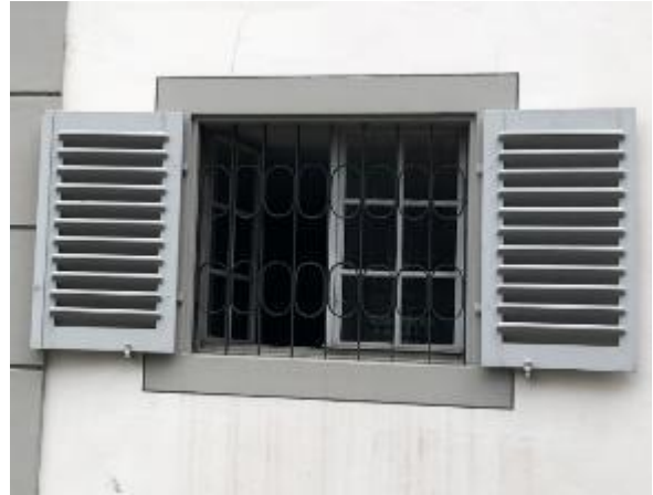
Abb. 177: Fenster Propstei im Stift Hof, Luzern EG. Umbau 1792, Läden mit fixen, vorstehenden Brettli. Die Neigung war so, dass das Wasser im geschlossenen Zustand nach aussen abfliesst.
