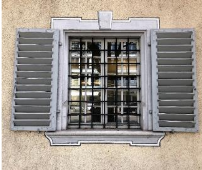
Abb. 74, 75: Läden mit beidseitig vorstehenden Lamellen im offenen und geschlossenen Zustand. Die Lamellen sind so angeordnet, dass im geschlossenen Zustand Regenwasser nach aussen abfließen kann.
