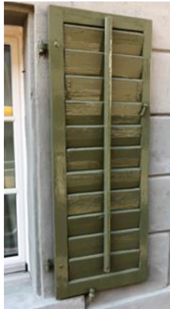
Abb. 86, 87: Deutlich sichtbar die Veränderung der Proportionen der Läden. Links mit schmalen Rahmen und breiten Brettli, ca. Anfangs 20. Jh.. Rechts breiter Rahmen und schmale Brettli, ca. 1950/60er-Jahre. Links ohne Brettlisteller, rechts mit Holzriegel als Brettlisteller.
