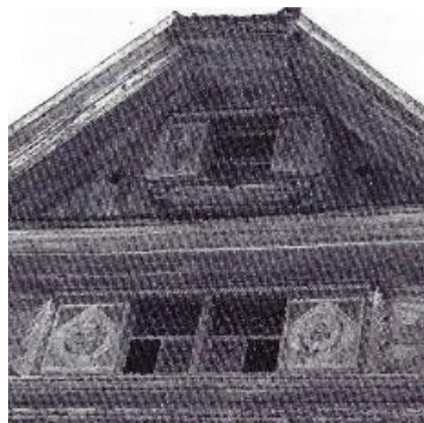
Abb. 339: Bauernhaus Nieder-Schongau, 1752. Zweifeldriges Fenster mit je einem Laden, Verkleidungen geschweift.
