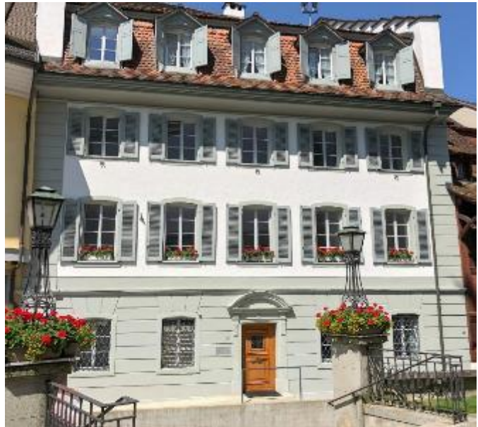
Abb. 178, 179: Pfarrhaus, Willisau, Fensterläden im 1./2. OG mit festen, bündigen Brettli, ähnliche könnten bei der Fassadengestaltung um 1800 schon eingebaut worden sein. Mansardendach mit gestemmtten Läden mit Füllungen.
