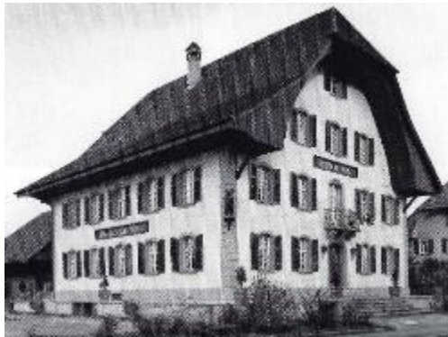
Abb. 327: Kölliken, 1777. Spätbarocker Bau mit Krüppelwalm und Ründi. Fenster Kreuzstock mit Stichbogen und Schlagläden.
