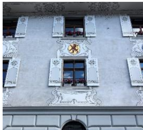
Abb. 35: Rathaus, Willisau, 1720. Läden mit Malerei, unten und oben mit bündigen Anfassleisten, welche übermalt sind.
