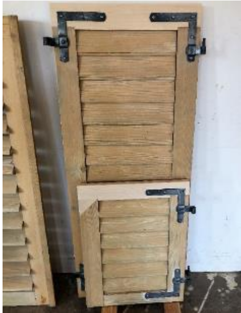
Abb. 370: Holzteile ersetzt an Läden nach dem Ablaugen. Vielfach sind das obere Querfries oder Ecken zuerst defekt.
