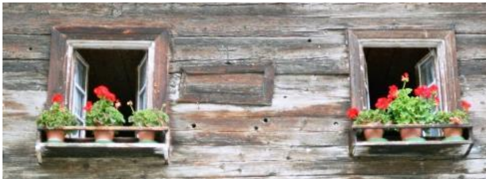
Abb. 350: Avers-Cresta, spätmittelalterliches Wohnhaus, zwischen den beiden Fenstern geschlossene Lüftungsluke/Seelenfenster.
