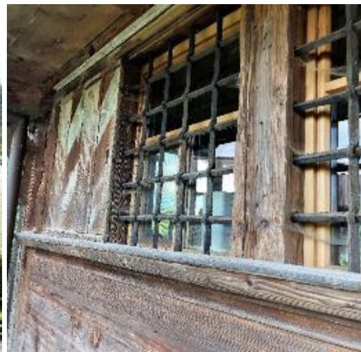
Abb. 336, 337: Bauernhaus Rüt matt, Ruswil, 1758. Links im EG der Giebfassade hat es Fallläden, in den Obergeschossen horizontale Schiebeläden. Rechts ursprüngliche Schiebeläden auf der Traufseite, welche geschützt unter der Laube sind.
