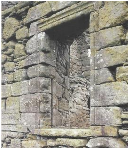
Abb. 164, 165: Baltersan Castle, Schottland, 1584. Foto links Schlitz von Tasche, in welcher die Läden versenkt wurden. Rechts Skizze der möglichen Situation.
