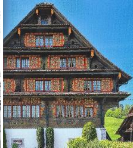
Abb. 334: Meierskappel, 1756, renoviert 1985. Fenster und Läden rekonstruiert nach alten, gefunden Mustern. EG Fallläden, OG Schiebeläden.
