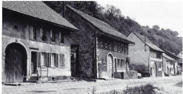
Abb. 325, 326: Beide Strassenzüge in Uerkeren, Mitte 19.Jh. Links im EG gegratete Läden, im OG Läden mit beweglichen Brettli, rechts nur im EG Läden.
