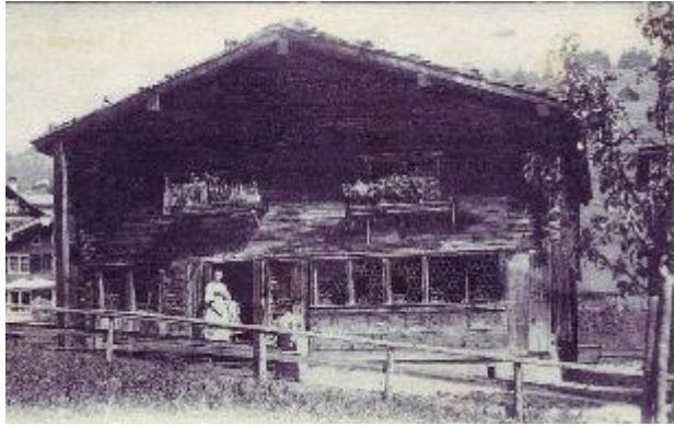
Abb. 294: Undatiert nach Renovation 1897. Nur die beiden zweifeldrigen Fenster haben Zugläden, die fünffeldrigen Fenster sind ohne Läden.
