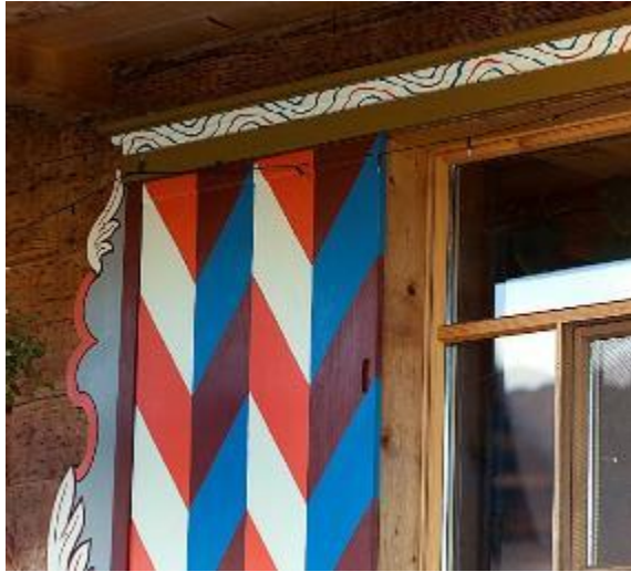
Abb. 6, 7: Bauernhaus Rützmatt, Ruswil, erbaut 1758. Die seitlichen Schiebeläden wurden nach einem unter der Konstruktion verbauten ursprünglichen Laden (rechts) behandelt. Man beachte die geschweiften Verkleidungen seitlich und die Verkleidung oben mit den passenden Malereien.
