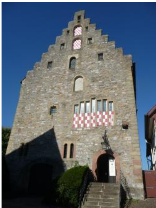
Abb. 144, 145: Steinhaus Bad Wimpfen, gotische Fenster mit Vertikalschiebeläden. Links Foto, rechts Schnitt.
