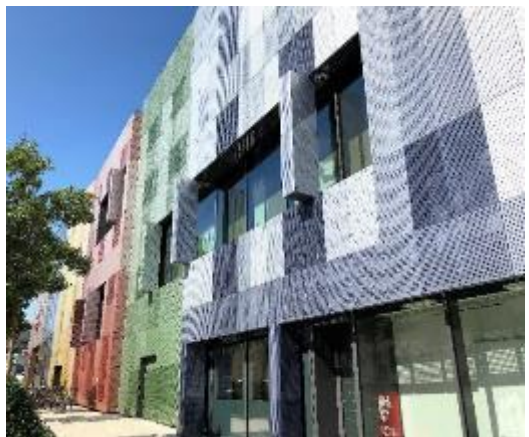
Abb. 268: Einkaufszentrum, Passau DE, 2009. Läden aus Lochblech, zum Teil Faltläden, aber nicht schliessbar, nur Schmuck.
