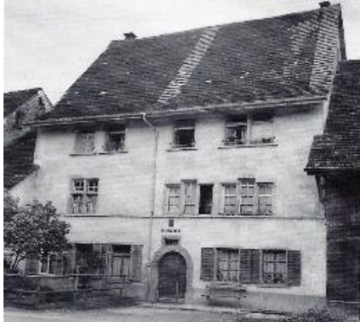
Abb. 323: Hornussen, 1596. Im 1. OG originale gotische Fenster ohne Läden. Im EG und 2. OG veränderte Fenster. Nur EG mit Fensterläden.
