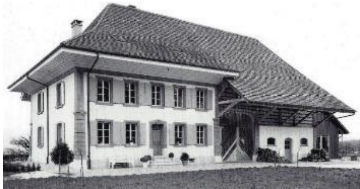
Abb. 328: Murgenthal, 1820. Klassizistischer Bau mit geknicktem Walmdach. Fenster rechteckig mit sechs Feldern und beidseitig Brettartigen Schlagläden, wie sie um 1820 schon aktuell waren.
