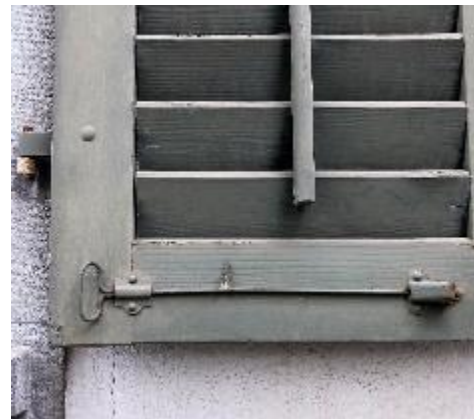
Abb. 116 bis 118: Links Vorreiber geschmiedet, Mitte Holzsetzholz, rechts Metallstift verkettelt.
