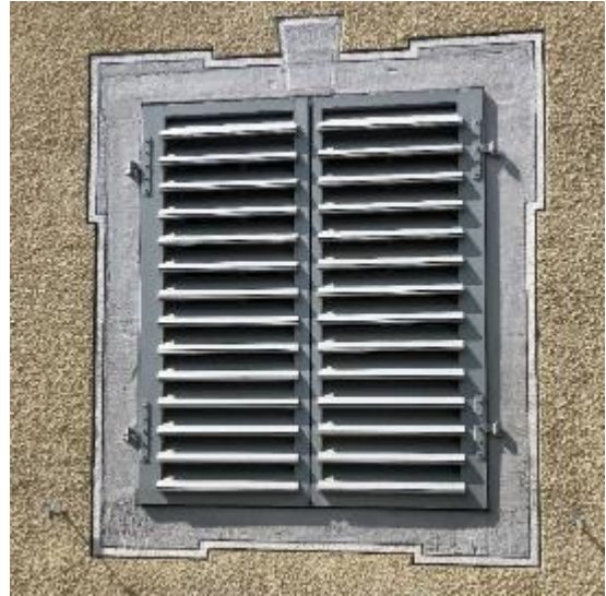
Abb. 74, 75: Läden mit beidseitig vorstehenden Lamellen im offenen und geschlossenen Zustand. Die Lamellen sind so angeordnet, dass im geschlossenen Zustand Regenwasser nach aussen abfließen kann.
