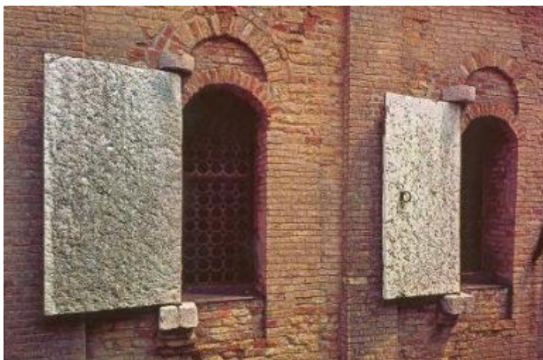
Abb. 136: Basilika Santa Maria Assunta, Torcello IT. Steinernen Läden mit Drehzapfen als Band.
