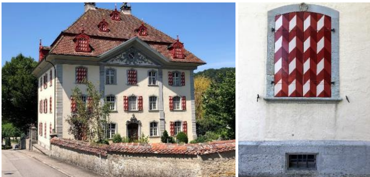
Abb. 173, 174: Pfarrhaus, Pfaffnau LU, ehemalige Sommerresidenz des Klosters St. Urban, 1764/1765. Die gegrateten Läden sind bewusst mehrfarbig bemalt. Die Fensterläden in den Farben der Zisterzienser sind ein massgebendes Gestaltungsmittel des Rokokopalais.
