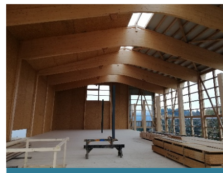
Intérieur de la ferme mise hors d'eau
