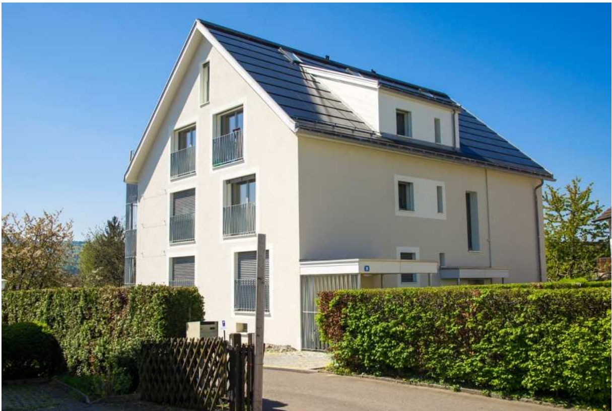
Abbildung 35: Sanierung MFH Hardegger, Oberengstringen, Bauatelier Metzler
