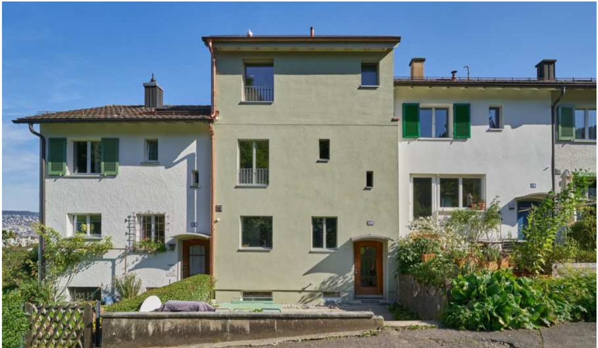
Abbildung 31: Umbau und Aufstockung Birmensdorferstrasse 618, Zürich, baubüro in situ
