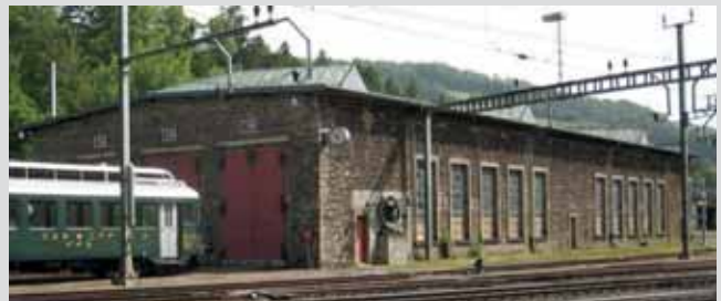
Remise Bahnhof Goldau
