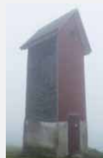
Die Eingangstüre ist aus Metall; das Zusammenspiel von Eternit- und Holzschindeln.
