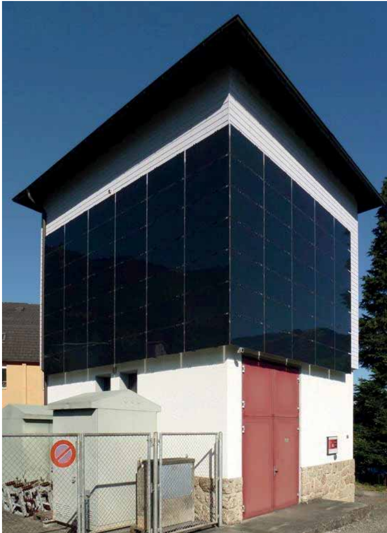
Der Goldauer Trafo TS Wichel ist zu einem kleinen Sonnenkraftwerk ausgebaut worden (Foto 2013). In der Zwischenzeit ist der Zähler entfernt worden (siehe aktuelle Foto S. 20).
