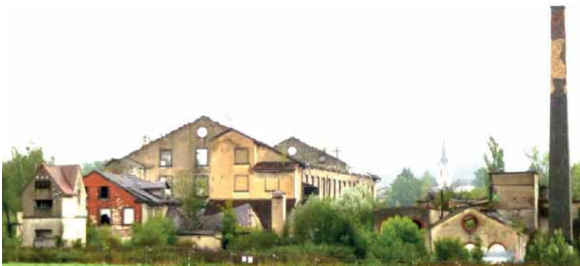
Die ehemalige Spinnerei Jakobstal bei Bülach mit Trafohaus mit Kreuzdach, Spinnereihallen mit eingefallenen Dächern, Maschinen- und Kesselhaus, Kamin. Als besterhaltenes Gebäude dieses Ensembles könnte der Trafo vorne links zukünftig eine führende Rolle einnehmen. Da die aktuelle Foto bei starkem Regen gemacht wurde, folgen auf der nächste Seite ein paar stimmungsvolle ältere Fotos.
