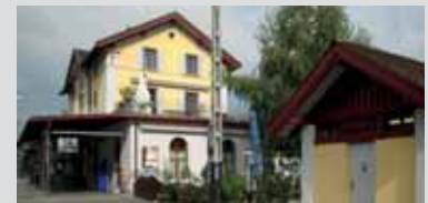
WC-Anlage und Stellwerk Bahnhof Küssnacht
