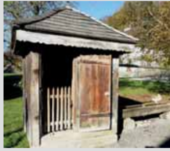
Sodbrunnen Wimmis BE
