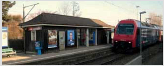
Wartehalle Freienbach SBB
