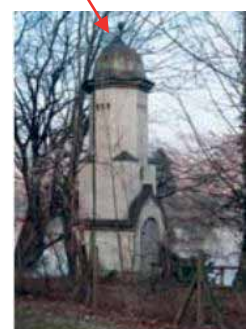
26 Transformatorhäuschen um 1905 Obere Limmatbrücke
