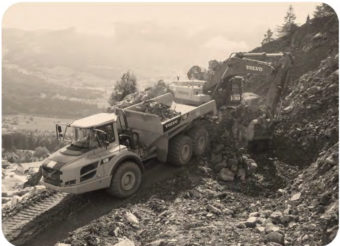
Transport mit 18m 3 Grossdumper von der Abbruchstelle, Blockgewinnung mit 60t Bagger mit Reisszahn, 2013 aus Firmenarchiv der Fa. Guber Natursteine AG
