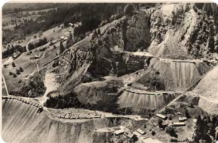
Abbau-Situation 1955 aus dem Firmenarchiv der Guber Natursteine AG
