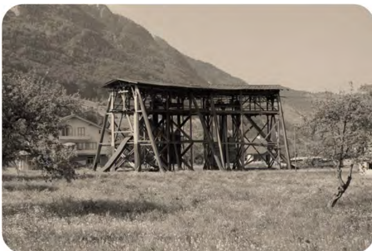
Alpnach-Grund. Umlenkgerüst für die Lorensseilbahn mit Abspanngewichten für die Trageile. Industriekultur pur! aus bebrail.ch – Foto Heinz Bircher, 22.05.1986
