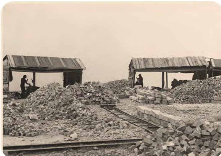
Steinrichter an der Arbeit in ihren Richterhäuschen mit «Mosaiki» im Vordergrund - aus dem Firmenarchiv der Guber Natursteine AG
