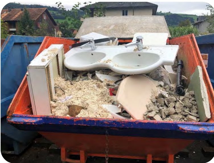
Ein typisches Bild auf unseren Baustellen Foto vom Autor, Herbst 2022
