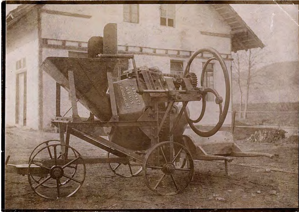
Betonmischer der Fa. Brun & Cie. Nebikon 1920-1930 aus pics-ethz.ch
