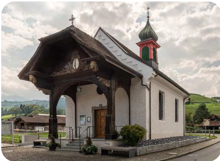
Fotografie nach der Sanierung, 2014 von Christian Dinkel, Horw
