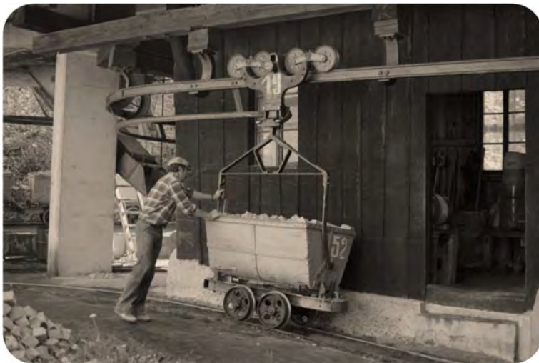
Bergstation der Seilbahn. Mutation der Feldbahn-Schienenfahrzeuge zu Seilbahnloren. Aus bebrail.ch – Foto Heinz Bircher, 22.05.1986
