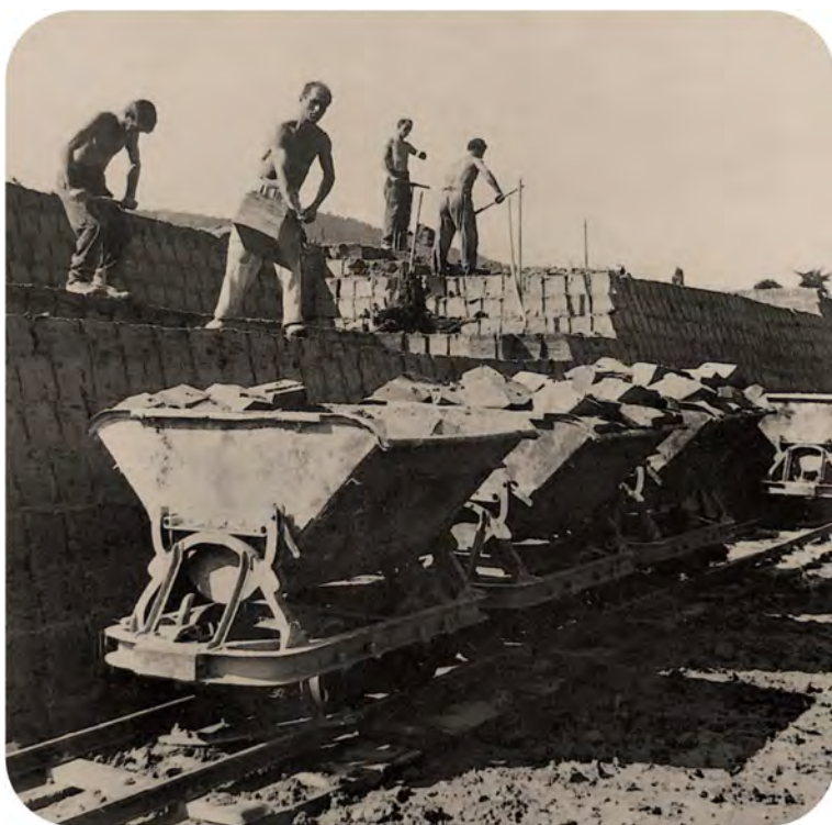
Stechen der Lehmblöcke in der Grube – Bild undatiert aus Firmenbroschüre 100 Jahre Ziegelei Horw-Gettnau-Muri
