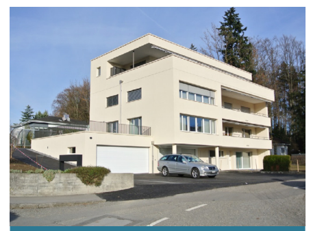
Aufstockung in Kastanienbaum in Rahmenbauweise
