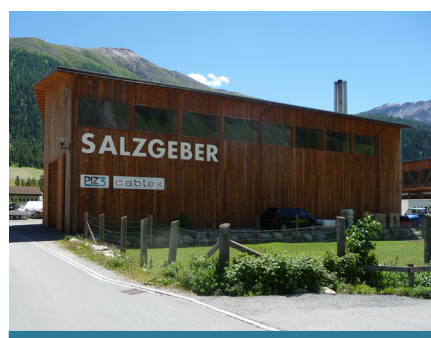
Heizzentrale in S-chanf
