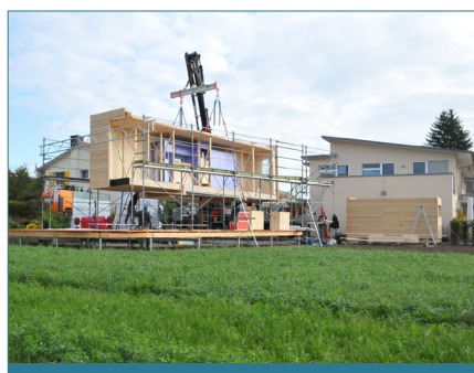
Montage eines Modulbaus
