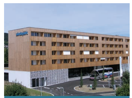
Mehrgeschossiger Holzbau von BLAG
