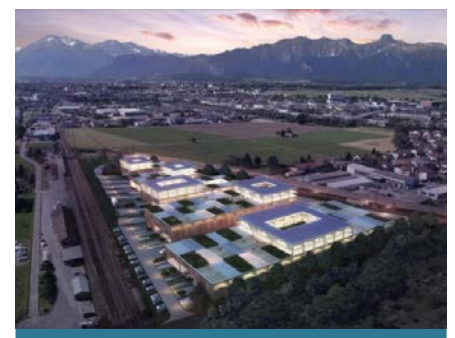
Das Aarefeld wie von Bauzeitarchitekten geplant
