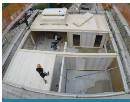
Chantier en phase de montage
