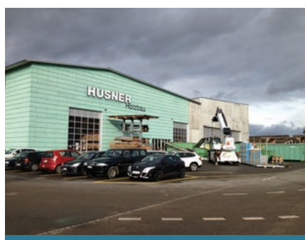
Vorplatz und Werkhalle der HUSNER AG Holzbau
