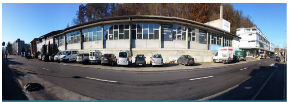
Ansicht Beer Holzbau AG
