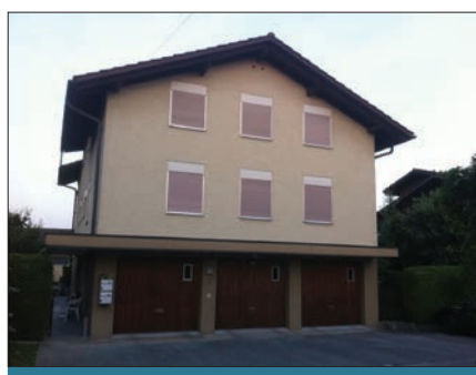
Nord-Ostfassade des bestehenden Gebäudes
