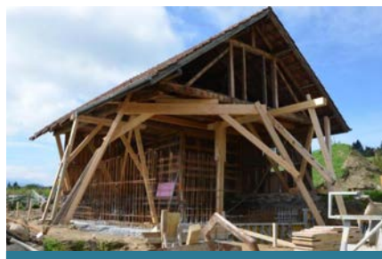
Fundament Ertüchtigung an einem Schopf
