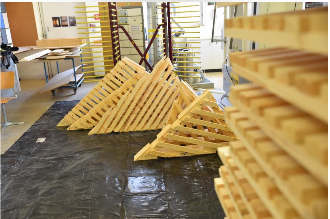
Brand- und Flammenschutz war ein zentrales Thema. Alle Holzbauteile wurden rundherum behandelt, mit einer flammhemmenden, farblosen auf Salz basierenden Lösung.
