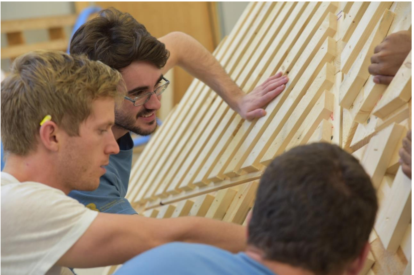
Die kurze Montagezeit von 2 Stunden leitet die Konstruktion: alles muss steckbar sein (BIM 4D).
