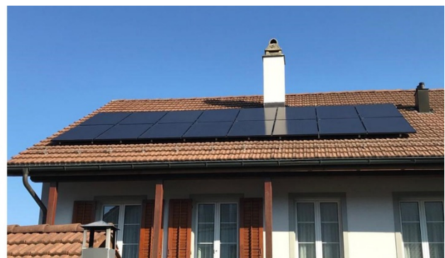
Abb. 49, Aufdachanlage in Winterthur
