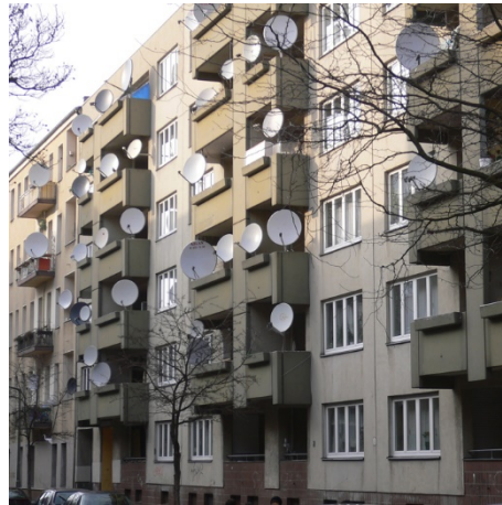
Abb. 3, Parabolantennen an der Fassade
