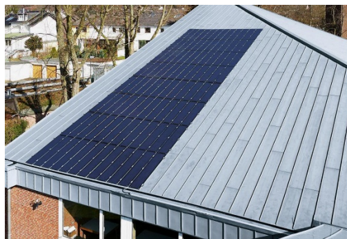
Abb. 61, Montage auf Stehfalzen
