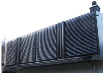
Abb. 16, Fassadenbefestigung
