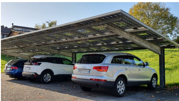
Abb. 39 und 40, Carports in Pultdachform, links sogar mit semitransparenten Modulen
