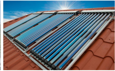
Abb. 18, Aufdachbefestigung
