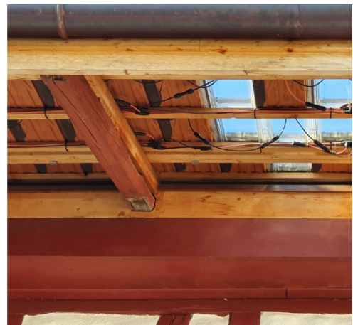
Abb. 95, Untersicht Dachüberstände und Aufdopplung der Konterlattung
