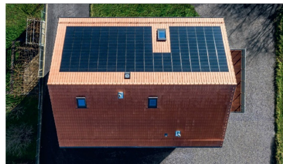
Abb. 58, Dachaufsicht der Indachanlage
