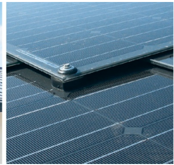
Abb. 56, Montage des Solarziegels
