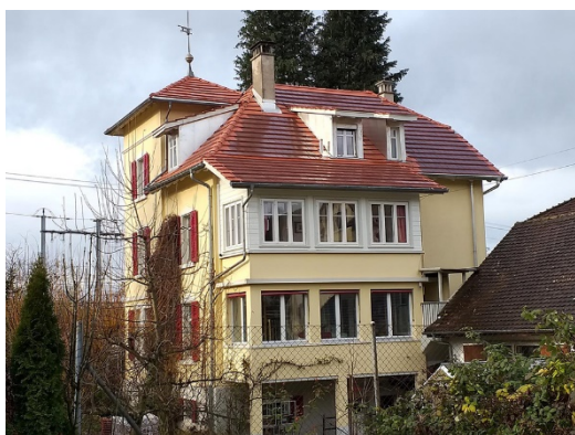
Abb. 73, Indachanlage mit rot eingefärbten Modulen
