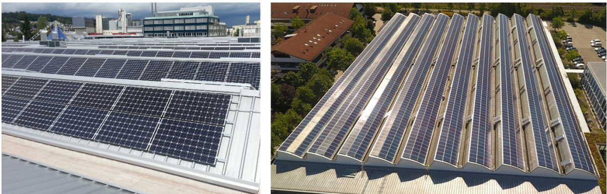
Abb. 31 und 32, Sheddächer mit Photovoltaikanlagen auf Industrieanlagen
