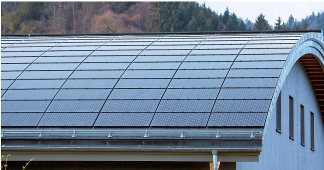
Abb. 37 und 38, Photovoltaikanlagen auf Tonnendächern
