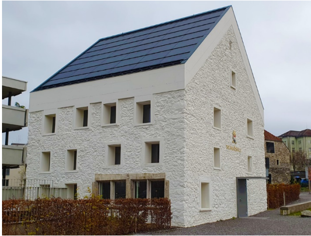
Abb. 50, Indachanlage in Wohlen
