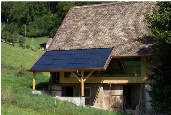
Abb. 44, Indachanlage oberhalb der Traufe im Schleppe Dach
