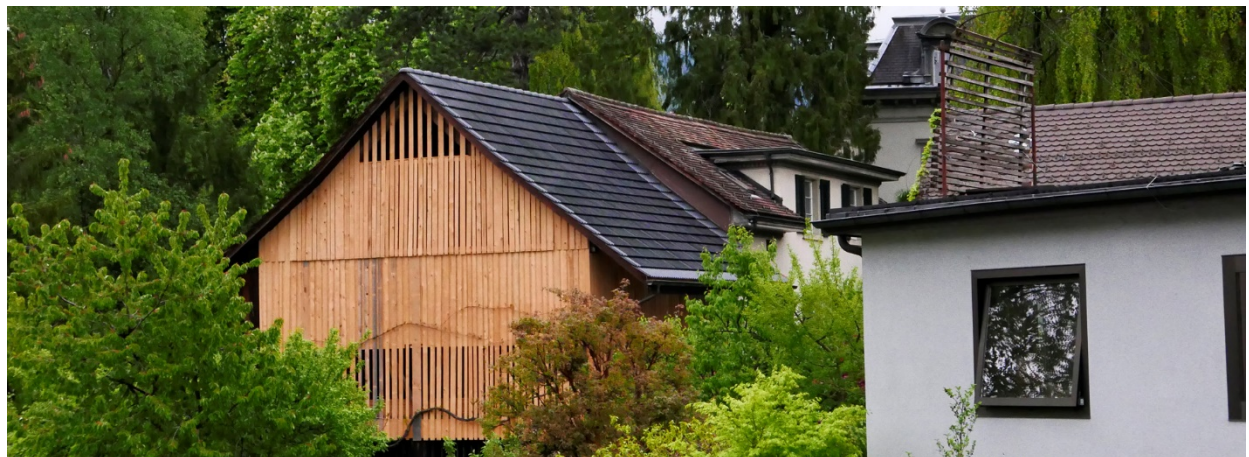
Abb. 87, Fernwirkung der PV-Anlage
