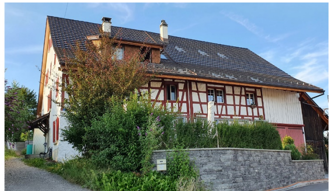
Abb. 92, Dach mit Solarziegeln eingedeckt
