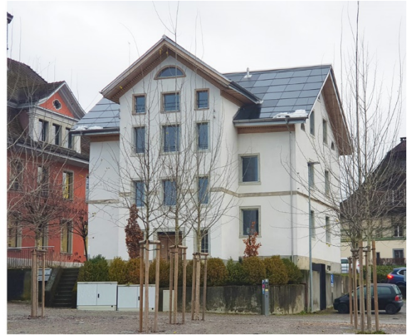
Abb. 51, Indachanlage in Wohlen mit Blindmodulen
