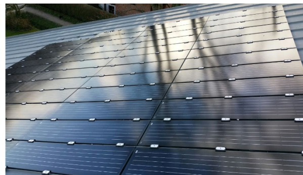
Abb. 62, Detail der Klemmhalterung
