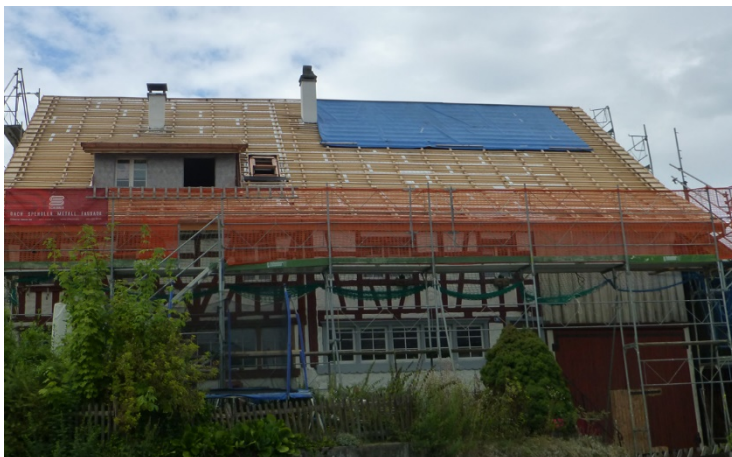
Abb.94, Unterdacharbeiten
