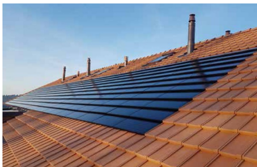
Abb. 57, Indachanlage, Module in Ziegelbreite
