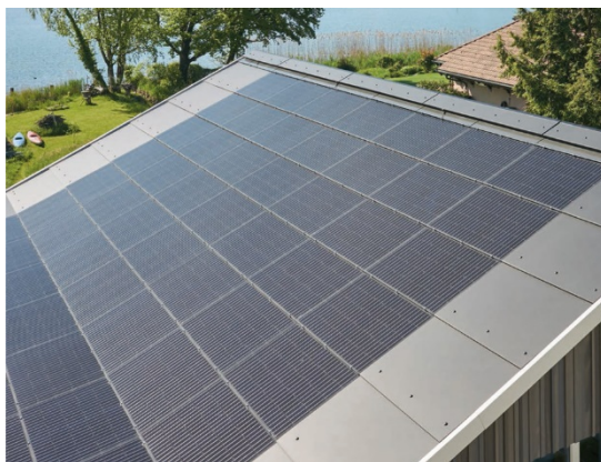
Abb. 79, Anordnung für eine Indachanlage
