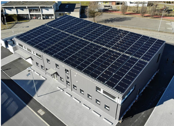
Abb. 35 und 36, Photovoltaikanlagen auf flach geneigten Dächern
