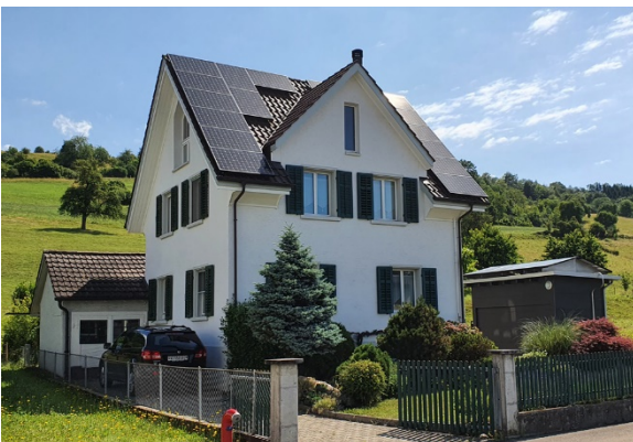
Abb. 46, Aufdachanlage mit Abstufungen in der Fläche
