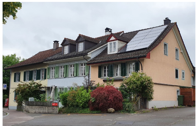
Abb. 47, Aufdachanlage oberhalb des Dachknicks
