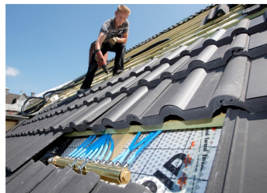
Abb. 66, Montage des Kollektors SolarPowerPack
