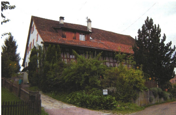
Abb. 91, Situation vor der Dachsanierung
