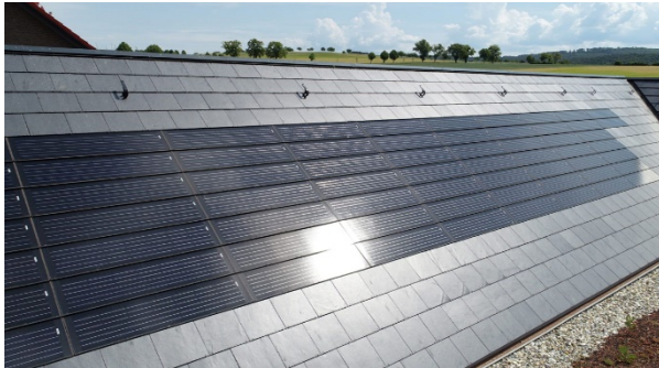
Abb. 59, Indachmontage auf Schrägdach
