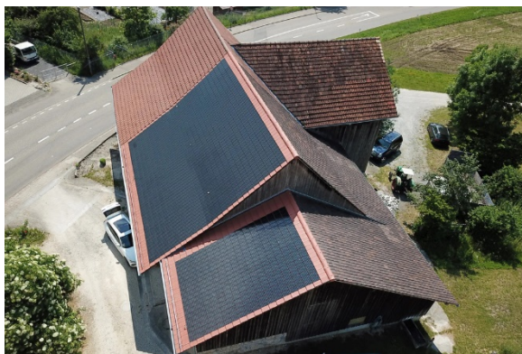
Abb. 71, Indachanlage in rotes Ziegeldach
