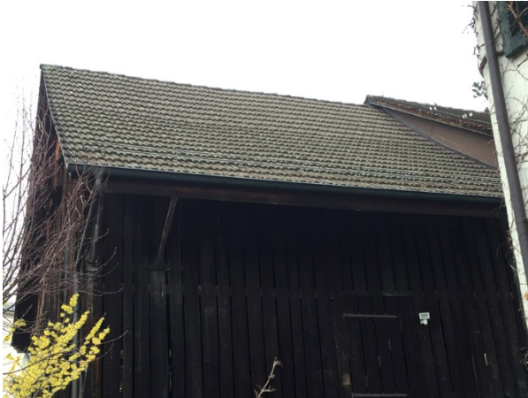
Abb. 85 Dach vor der Sanierung
