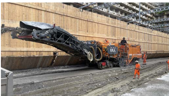
Kaltfräse im Einsatz | RBS Bahnhof Bern
