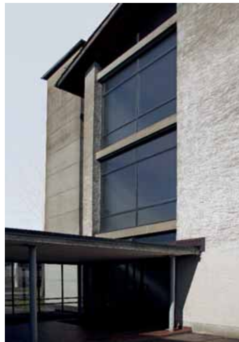
Bilder 59 und 60: Verputzte Stirnfassade mit grosszügiger Treppenhausbefensterung und gedeckter Verbindung zur Turnhalle, 2014. Opake Verglasung mit fein dimensionierten schwarzen Stahlprofilen. Betonelement auf der Höhe der Deckenstirne
