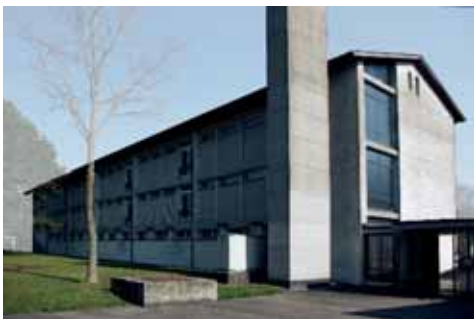
Bilder 59 und 60: Verputzte Stirnfassade mit grosszügiger Treppenhausbefensterung und gedeckter Verbindung zur Turnhalle, 2014. Opake Verglasung mit fein dimensionierten schwarzen Stahlprofilen. Betonelement auf der Höhe der Deckenstirne
