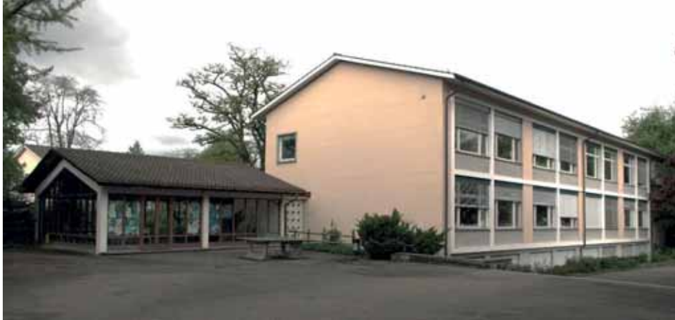
Bild 113: Ansicht Hauptfassade Primarschulhaus mit vorgelagerter Pausenhalle, 2014
