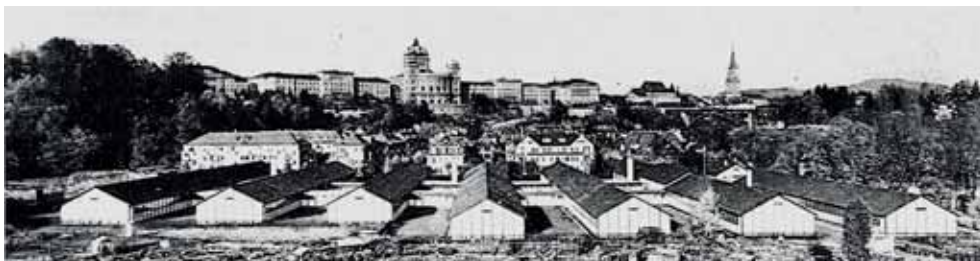
Bild 15: Marzlimoos Bern. Bürostadt der Kriegs-, Industrie- und Arbeitsamtes K.I.I.A., eigens für den Vollzug der Rationierungsmassnahmen aufgebaut
