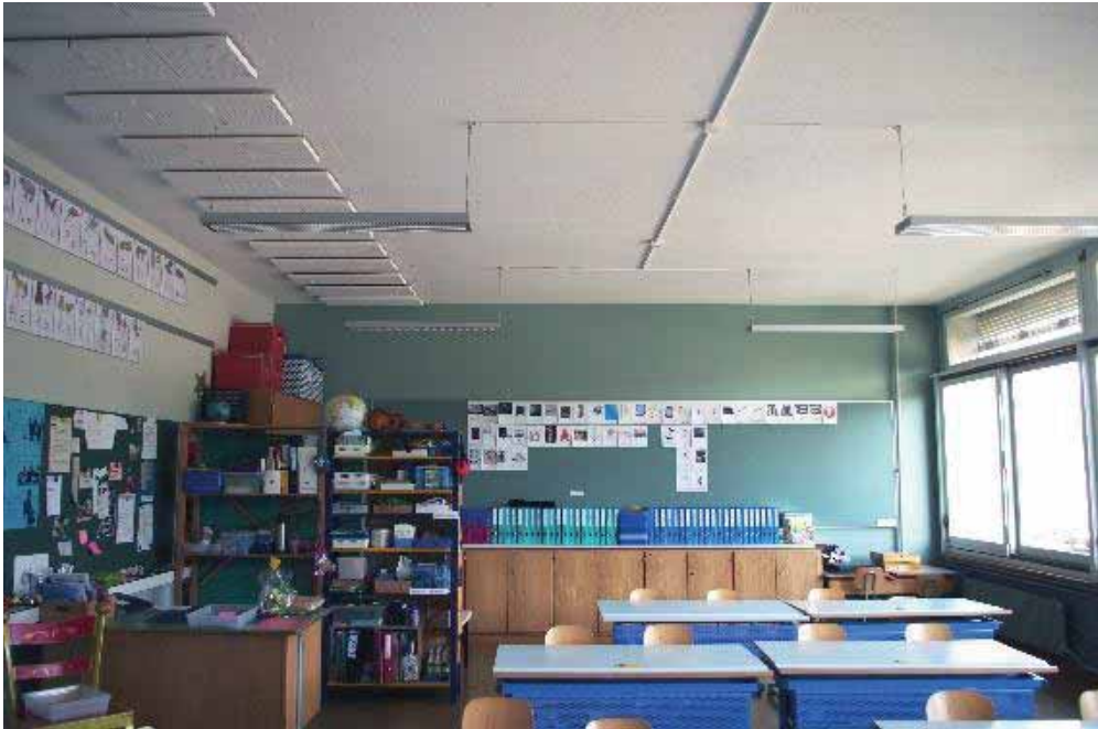
Bild 73: Klassenzimmer, 2014: ursprüngliche Farbigkeit und Ausstattung weitgehend erhalten. Wände verputzt und in differenzierten Grüntönen gestrichen, Decke Beton weiss gestrichen, entlang der Längswand Decken-Akustikplatten
