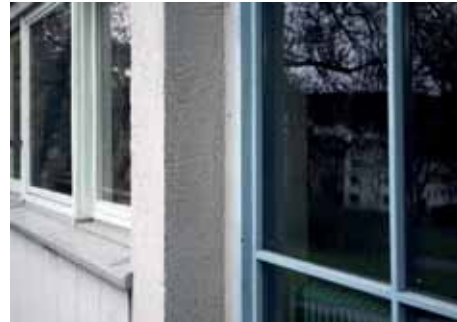
Bild 91: Farbige Befensterung, 2014: Metallfenster in hellblau, Holzfenster in hellgrün (Originalfarbigkeit nicht bei allen Fenstern erhalten)
