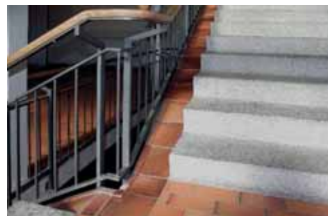
Bild 67: Geländerdetail und aufgesattelte Treppenstufen aus Granit, 2014
