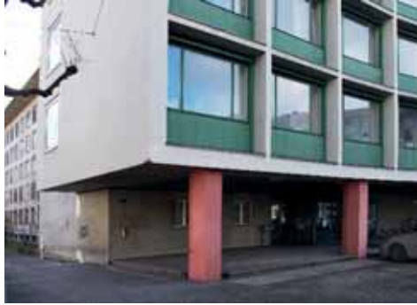
Bild 33: Oberzolldirektion, Bern, 2014 Typische Farbigkeit: Tragstruktur in grau, Ausfachungen und Stützen in rot-grün
