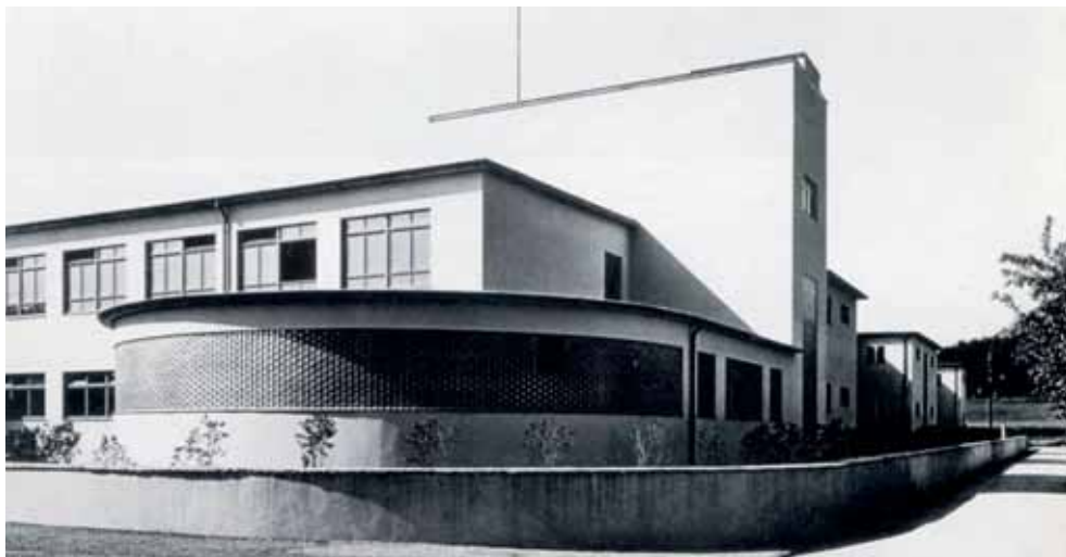
Bild 50: Schulhaus Stapfenacker, Bern (1930-31). Aufnahme um 1931. Architekt: K. Indermühle
