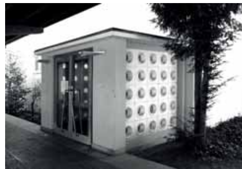
Bild 117: Windfang Primarschulhaus mit Beton-Glas-Elementen, 2014
