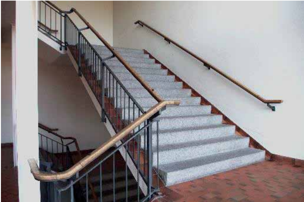
Bild 64: Haupttreppenhaus, 2014. Wände verputzt, hellgrüner Anstrich, Decken Beton weiss gestrichen, Boden Klinker, aufgesattelte Granitstufen, Geländer Metallstaketen anthrazit, Handläufe Eiche
