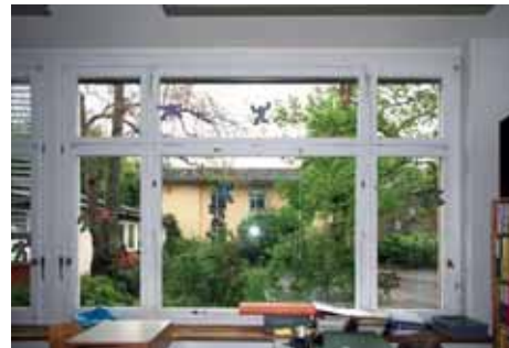
Bild 122: Befensterung in Holz mit mittigem Schwingflügel, seitlichen Drehflügeln und Klappflügeln im oberen Bereich, 2014
