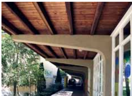
Bild 116: Einseitig verglaster Laubengang mit Betonträgern, 2014. Verbindende Ost-West-Erschliessung des Areals
