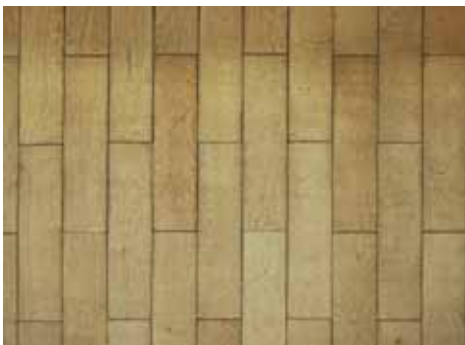
Bild 74: Farbigkeit Klassenzimmer, 2014: Stirnwände in dunklerem Grünton, Längswand in hellerem Grünton, Bodenbelag: Riemenparkett Eiche
