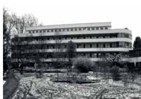
Bild 10: Säuglingsheim Elfenau, Bern Architekt: O. Salvisberg
