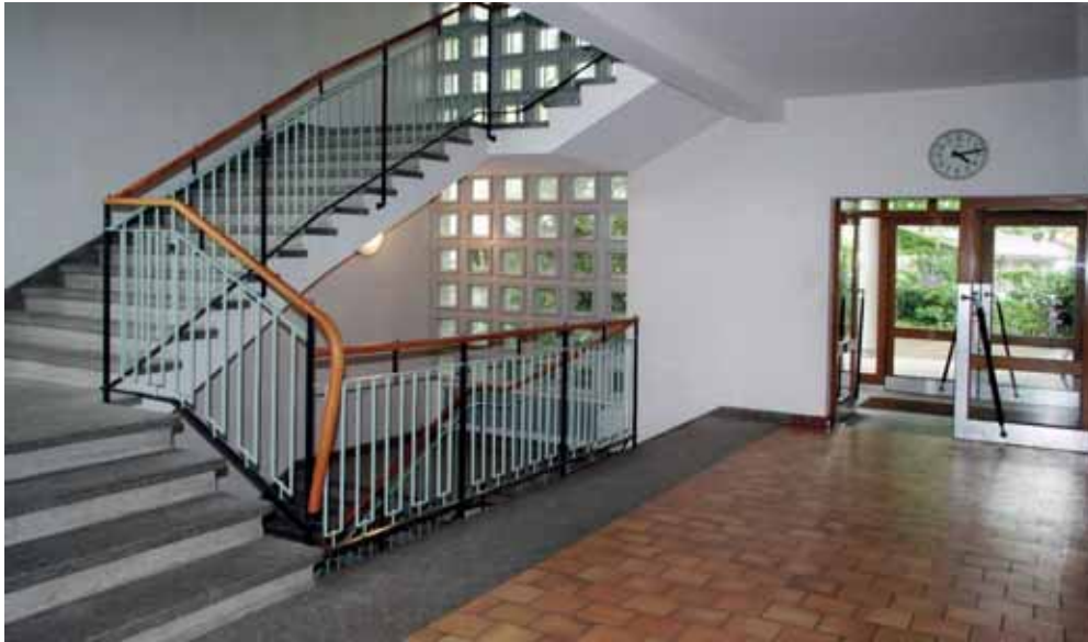
Bild 118: Treppenhaus, 2014. Bodenbeläge in gelbem Klinker und Granit. Geländer Metallstaketen hellgrün und schwarz, Handlauf Eiche. Befensterung Glas-Beton-Elemente
