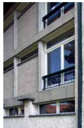
Bild 55 und 56: Schrägansicht Rückfassade, 2014: analoger Aufbau wie Hauptfassade, jedoch mit zu Oblichtbändern verkleinerten Öffnungen. Befensterung Korridor in Holz, weiss gestrichen, Geländerabdeckung grün
