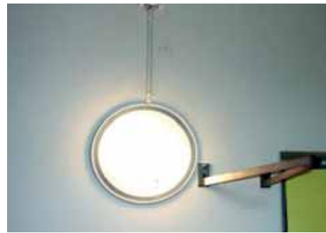
Bild 120: Bauzeitliche Wandleuchte im Korridor, 2014
