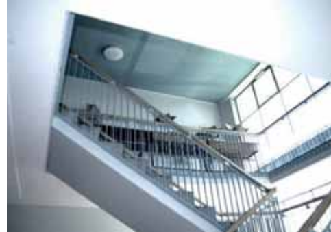
Bild 99: Untersicht Treppenhaus, 2014: Decke Holztäfer, Untersicht Treppenläufe und Wände in Blautönen
