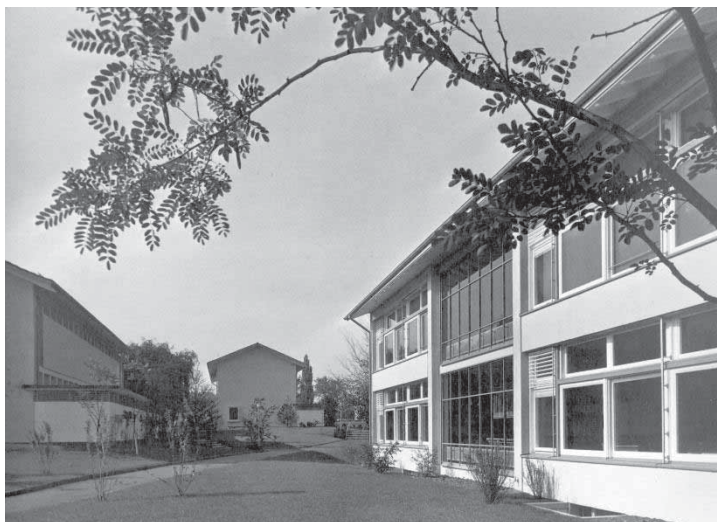
Bild 87: Schrägansicht der Hauptfassade, um 1953
