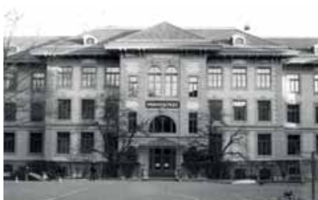
Bild 47: Primarschulhaus Länggasse, Bern Ansicht vom Pausenplatz, 2014
