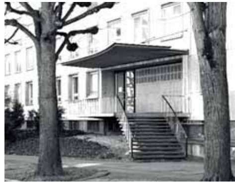
Bild 25: Oberzolldirektion, Bern, 2014 Seitentreppe mit Vordach
