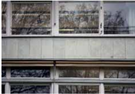
Bild 90: Hauptfassade, 2014: Brüstungsbereiche mit Betonelementen
