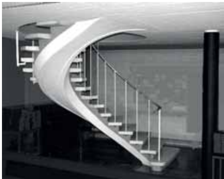
Bild 24: Kirche Bruder Klaus, Bern, 2014 Freischwingende Treppe zur Empore
