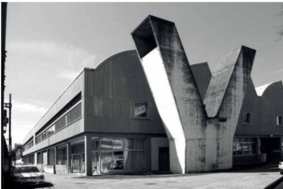
Bild 128: Fabrikgebäude für die Textilfirma Schild AG (1958-59), 2014. Charakteristisch ist der Y-förmig ausgebildete Lüftungskamin.
