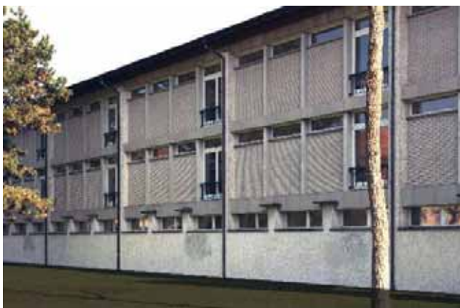
Bild 55 und 56: Schrägansicht Rückfassade, 2014: analoger Aufbau wie Hauptfassade, jedoch mit zu Oblichtbändern verkleinerten Öffnungen. Befensterung Korridor in Holz, weiss gestrichen, Geländerabdeckung grün
