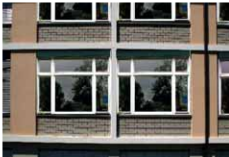
Bild 114: Hauptfassade, 2014. Tragende Hauptpfeiler gelb verputzt, vorgeblendetes Betonraster, ausgefacht mit Kalksandsteinen
