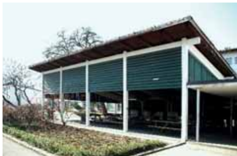
Bild 78: Gedeckte Pausenhalle mit Pultdach und Stulpschalung, 2014
