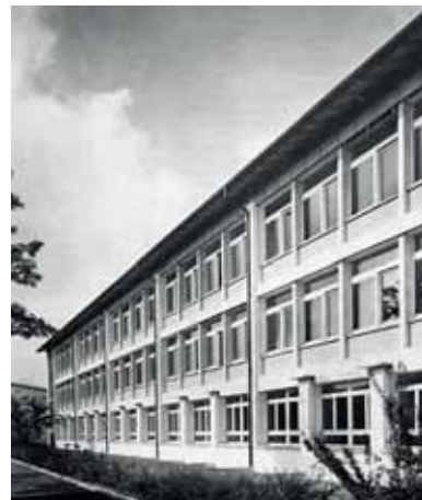
Bild 135: Schule Statthaltergut, Plastizität der Fassade
