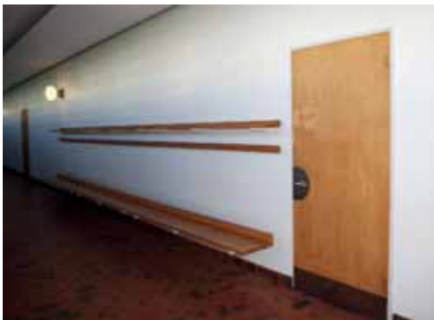
Bild 69: Korridore, 2014: Wandbündige Türen mit Holzfurnier, Sitzbank und Kleiderhaken
