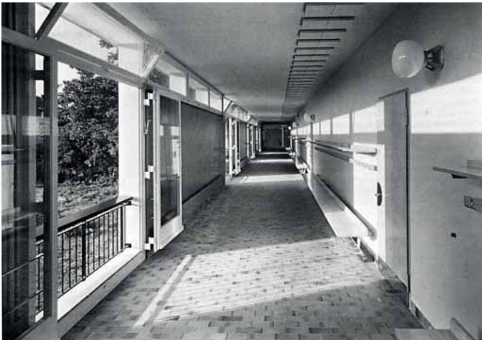
Bild 63: Korridor mit grossflächig öffnenbaren Fenstern, 1950
