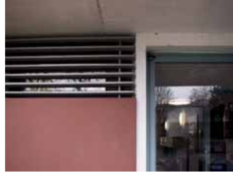
Bild 34: Schulanlage Steigerhubel, Bern. Reinhard Architekten, 2014 Farbigkeit der Profilierung des Eingangsbereiches rot-weiss-hellgrau-hellblau
