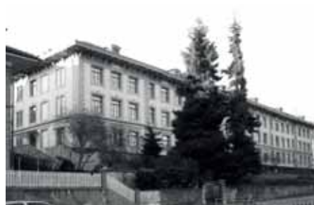
Bild 48: Primarschulhaus Länggasse, Bern Ansicht Strassenseite, 2014
