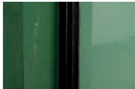
Bild 72: Farbige Windfänge, 2014: Verputz grün gestrichen, Metallprofile schwarz, opakes Glas
