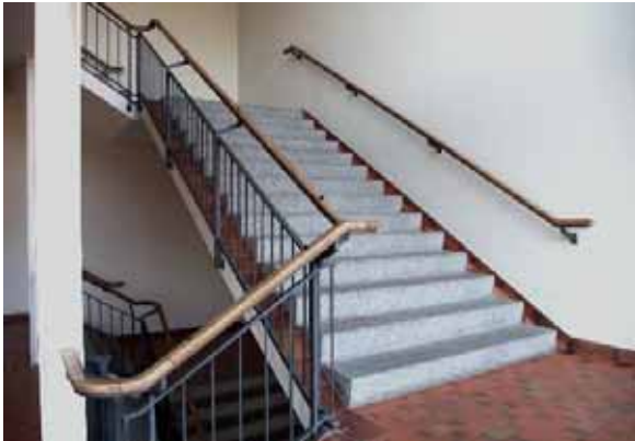
Bild 136: Schule Statthaltergut, Haupttreppenhaus
