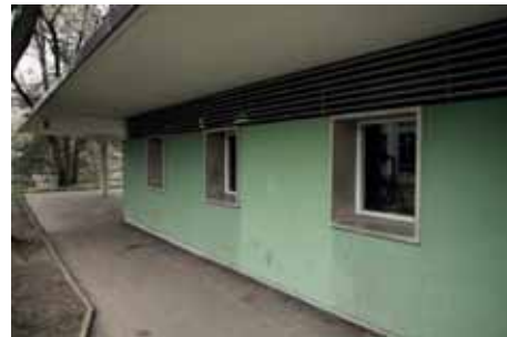
Bild 93: Rückwärtige Raumschicht mit La- mellen vor Oberlichtband und kunststein- eingefassten Lochfenstern, 2014
