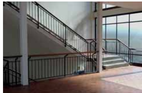
Bild 66: Haupttreppenhaus, 2014: Tragstruktur aus H-Profilen (Stahl), weiss gestrichen
