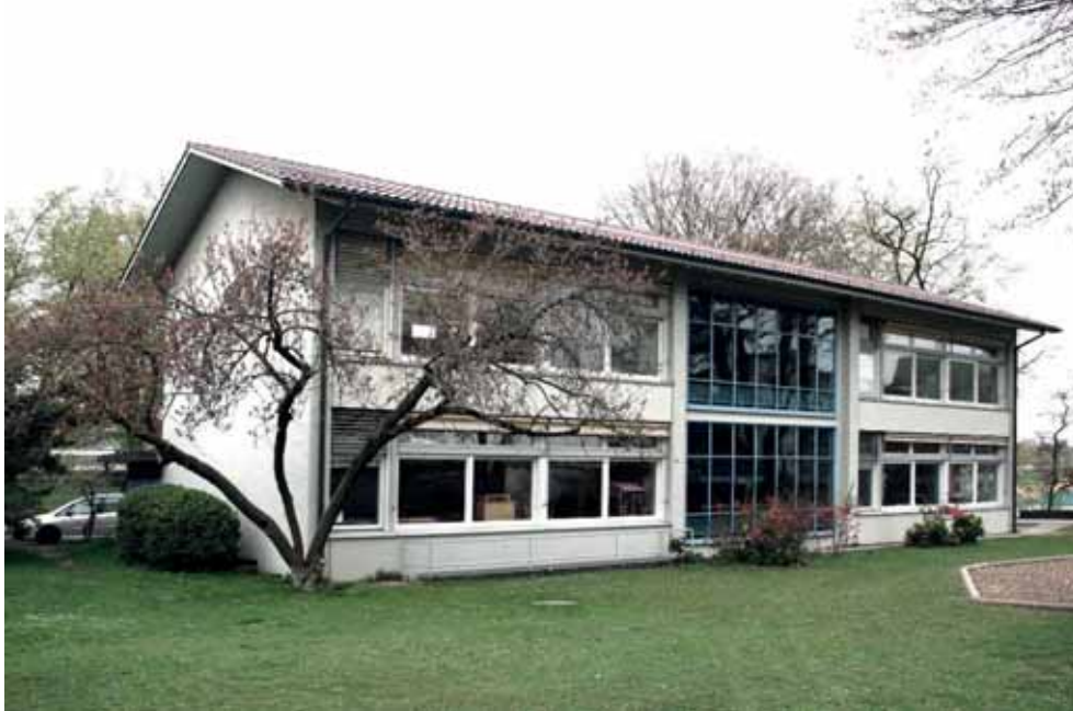
Bild 88: Hauptfassade, 2014: Klassenzimmer mit hellgrünen Holz-Schiebefenstern und Brüstungen mit Betonelementen, Treppenhausfassade mit hellblauen Metallprofilen
