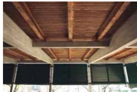
Bild 79: Tragstruktur der Pausenhalle mit Betonträgern, 2014
