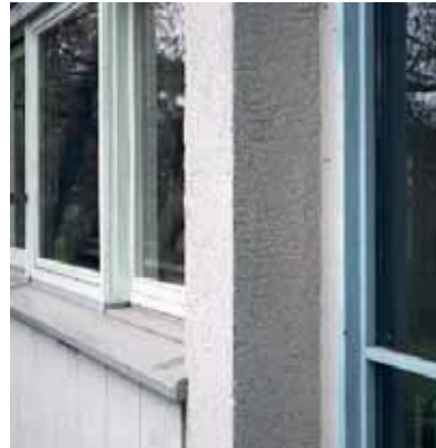
Bild 137: Schule Steigerhubel, Treppenhausbefensterung in Metall Schiebefenster in Holz
