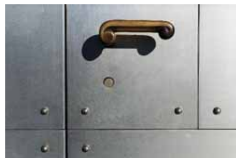
Bild 29: Kirche Bruder Klaus, Bern, 2014 Haupteingangstüre mit genietetem Aluminiumblech, Türgriff in Messing
