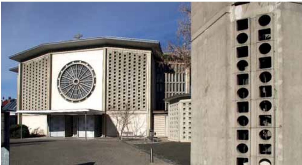
Bild 21: Kirche Bruder Klaus, Bern (1953/54), 2014. Architekt Hermann Baur. Polygonaler, gegliederter Baukörper mit freistehendem Glockenturm
