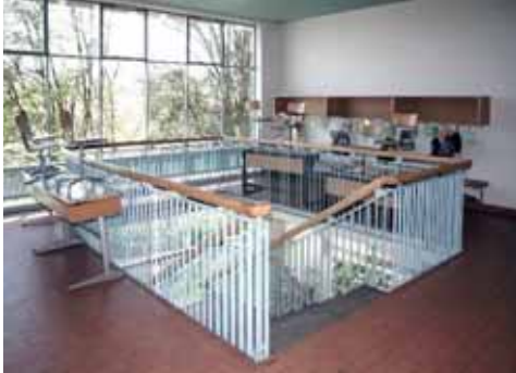
Bild 98: Treppenhaus Obergeschoss, 2014: Boden Klinker, Stufen Kunststein, Geländer Metallstaketten hellblau, Handlauf Eiche
