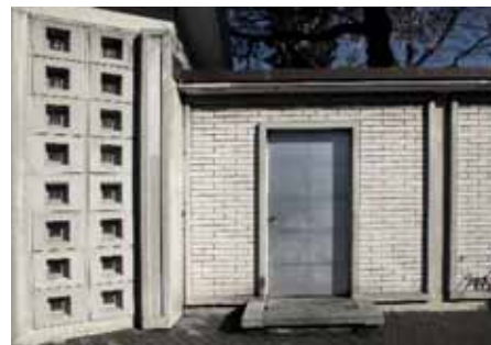
Bild 23: Kirche Bruder Klaus, Bern, 2014. Einfassungsmauer Vorplatz. Profilierte Be- tonstruktur mit Ausfächung durch Kalksandsteine
