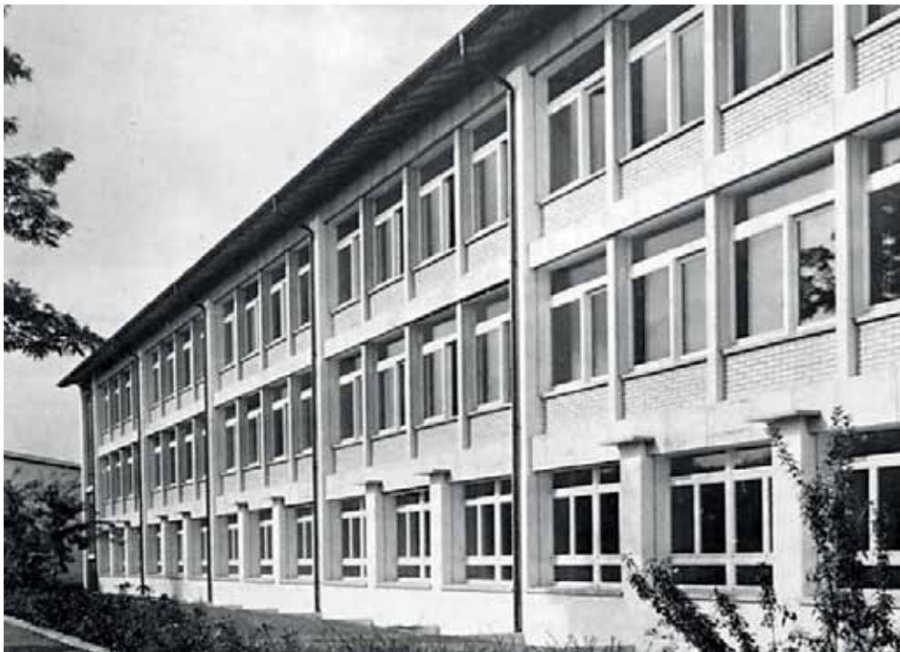
Bild 26: Schulanlage Statthaltergut (1949-51), Bern, um 1950. Architekt: Hans Brechbühler. Südfassade, mit Kalksandsteinen ausgefachte Betonrahmenkonstruktion. Formal kühner Übergang von der Dreiteiligkeit des Sockelgeschosses zur Vierteiligkeit der Obergeschosse
