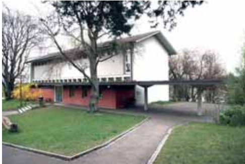
Bild 138: Schule Steigerhubel, Eingangspartie und rückseitiger Nebenraumbereich
