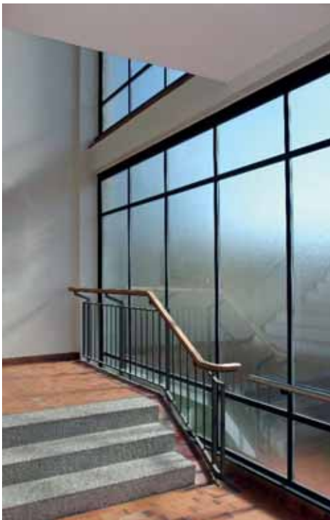
Bild 65: Verglasung Haupttreppenhaus, 2014: schwarze Metallprofile, opake Verglasung, partiell mit Klarglas
