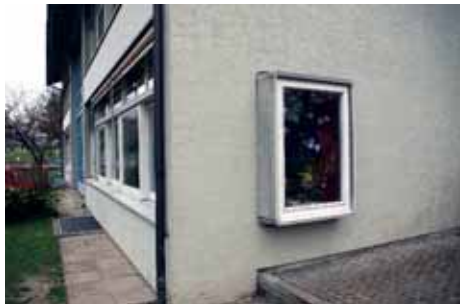
Bild 92: Überecksituation Haupt- und Stirn- fassade mit Blumenfenster, 2014
