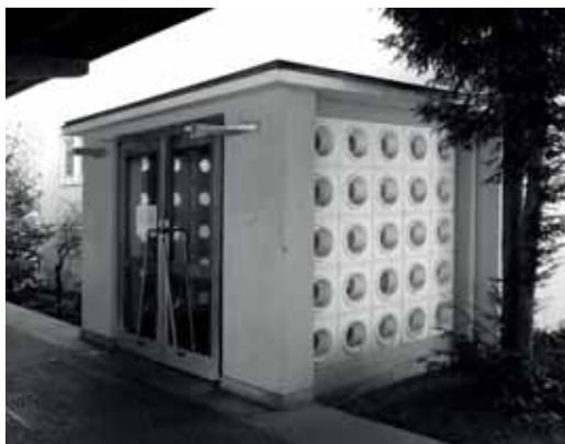
Bild 140: Schule unteres Murfeld, Windfang mit ornamentalen Glas-Betonelementen
