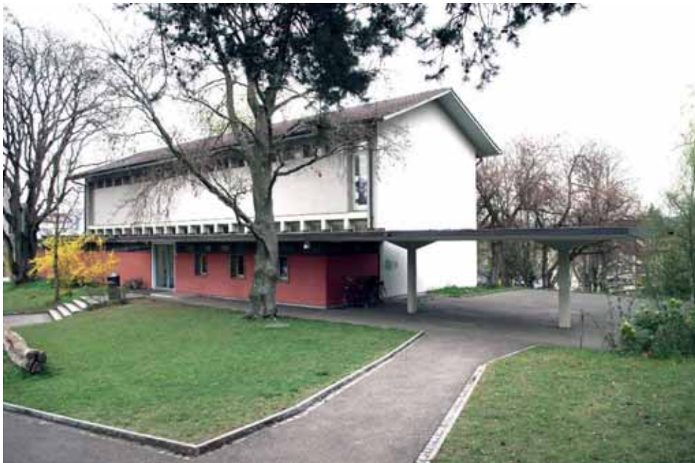
Bild 89: Rückfassade, 2014: Verputztes Mauerwerk und vorgelagerte Nebenraumschicht mit gedecktem Pausenbereich. Die Farbigkeit der rückwärtigen Raumschicht variiert pro Pavillon. Gut sichtbar die Oblichtbänder der Klassenzimmer
