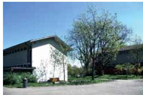
Bild 108: Im Vordergrund Pausenplatz und durchgrünter Raum zwischen den Pavillons, 2014
