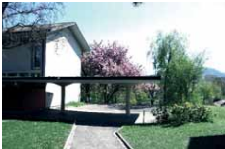
Bild 105: Gedeckter Aussenbereich mit Strauchbepflanzung, 2014
