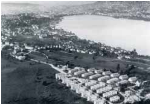
Bild 7: Siedlung Neubühl, Zürich. Architekten: M.E. Häfeli, P. Artaria, H. Schmidt, E. Roth, C. Hubacher
