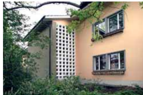
Bild 115: Rückfassade, 2014: Mauerwerk gelb verputzt. Fenstereinfassungen in Granit. Treppenhaus vorgebaut, mit Sandstein verblendet. Befensterung mit Glas-Beton-Elementen
