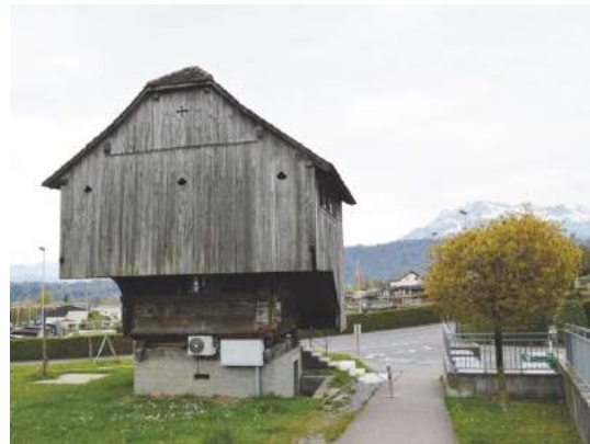
Abb. 162 Speicher Schönbühl, Emmen. Technische Aufrüstung für die Nutzung als Hofladen. (Verf. 2023)
