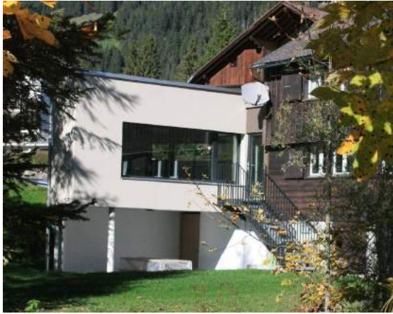
Abb. 75 nachträglich erstellter Anbau gartenseitig, Speicher Flühli. (Vermietungsplattform e-domizil.ch, 1.10.2023)
