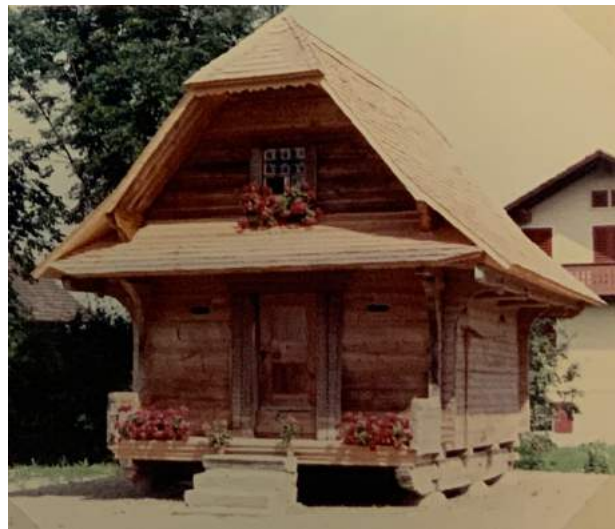
Abb. 106 Restaurierter Speicher am neuen Standort auf dem Areal der Zimmerei Haupt, Ruswil 1970. (1970 in Fotothek kant. Denkmalpflege Luzern)
