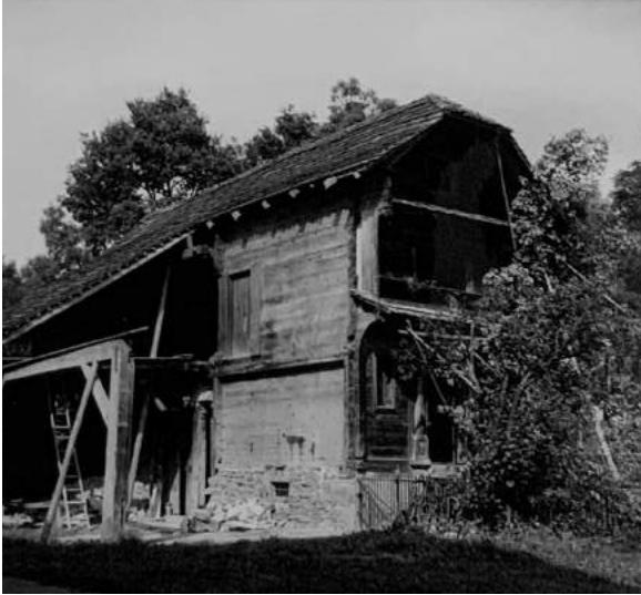
Abb. 153 Speicher Stechenrain-Mühle, Littau, Verlust der Lauben werden bei Abbrucharbeiten sichtbar. (Ernst Brunner 1961)
