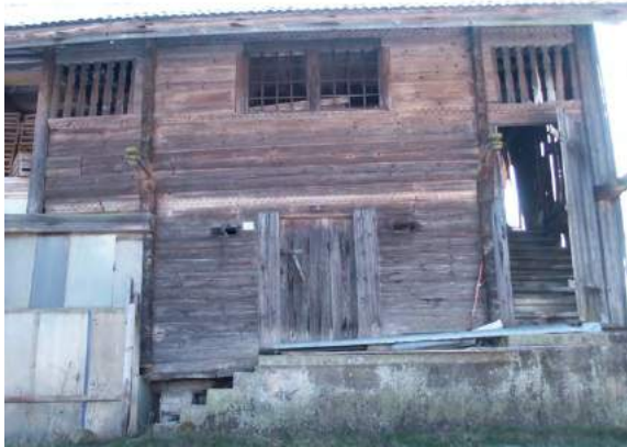
Abb. 125 Speicher Burst, Werthenstein, datiert 1727. (Bauinventar kant. Denkmalpflege Luzern)
