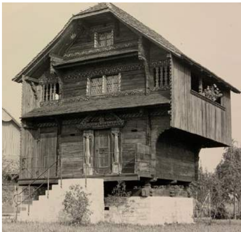
Abb. 28 Frontseitige Laubengitter und seitlich offene Laube am Beispiel des Speichers Schönbühl in Emmen, datiert 1717. (Felber 1962 aus Fotothek kant. Denkmalpflege)
