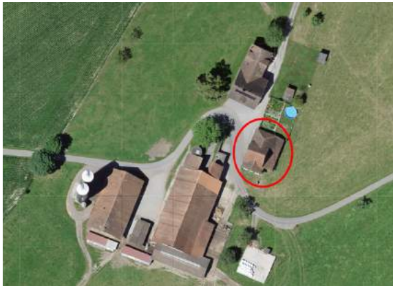
Abb. 133 Luftbildaufnahme 2020, Hof Löchenrain, Rothenburg. (swisstopo, online 10.06.2023)
