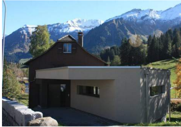
Abb. 76 nachträglich erstellter Anbau, strassenseitig, Speicher Flühli. (Vermietungsplattform e-domizil.ch, 1.10.2023)
