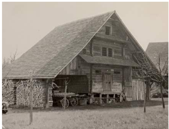
Abb. 148 Speicher Hermolingen, Rothenburg mit Anbauten um 1957. (Dolf Hüppi 1957, aus Bauernhausinventar)
