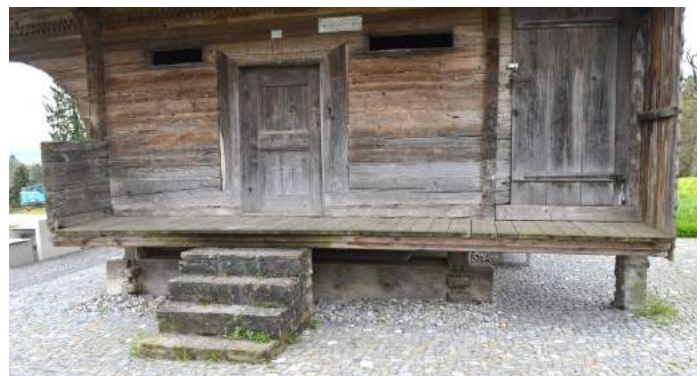
Abb. 23 Speicherschoss am Beispiel des Kornspeichers Hermolingen in Rothenburg, datiert 1664. (Verf. 2023)
