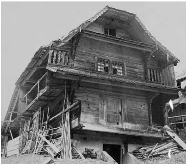
Abb. 91 Speicher Hinter-Längenbach, Luthern. Ansicht von Osten. (Ernst Brunner 1958, in Bauernhausinventar)
