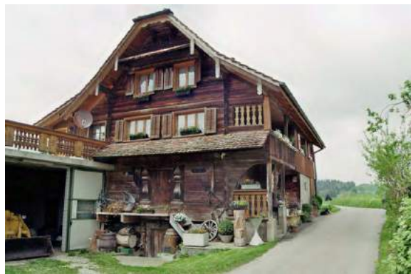
Abb. 58 Beispiel Wohnhaus (Stöckli), Speicher Hapfig, Ruswil. (Bauinventar, kant. Denkmalpflege Luzern)
