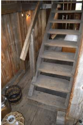
Abb. 33 Treppenaufgang auf der Rückseite des OG am Beispiel des Speichers Schönbühl in Emmen (Verf. 2023)
