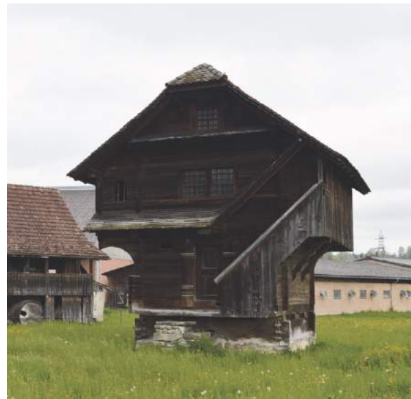
Abb. 25 Beispiel eines giebelseitigen Treppenaufgangs beim Speicher Waltwil in Emmen, datiert 1704 (Verf. 2023)
