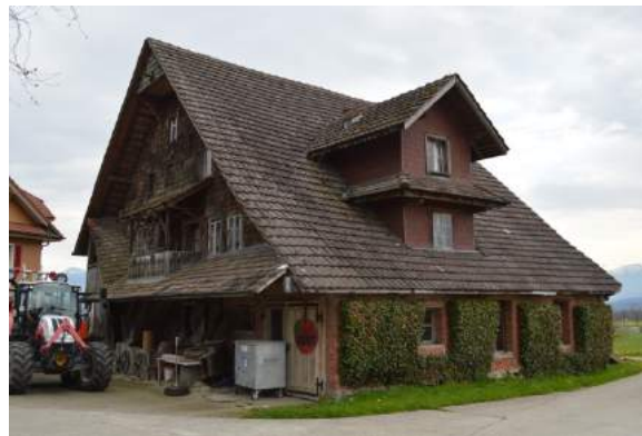
Abb. 130 Speicher Oberhocken, Rothenburg, Seitenansicht. (Verf. 2023)
