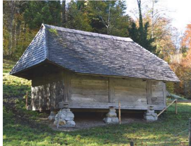
Abb. 11 Terrainausgleich mithilfe der Punktfundamente am Beispiel des Käsespeichers aus Wasen BE auf dem Ballenberg, datiert 1785. (Verf. 2021)
