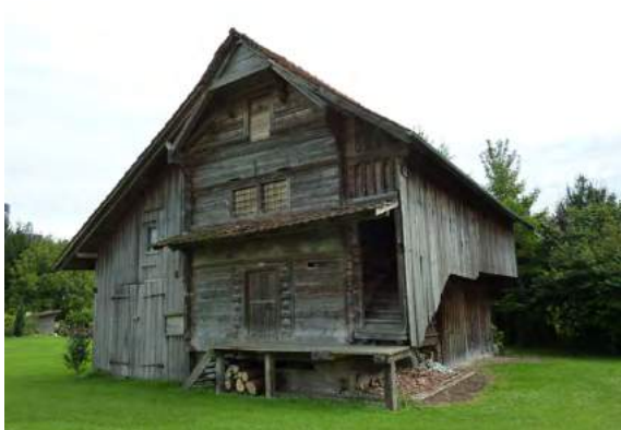
Abb. 121 Speicher Mettlenstrasse, Eschenbach, aus spätem 17. Jh. (Bauinventar kant. Denkmalpflege Luzern)
