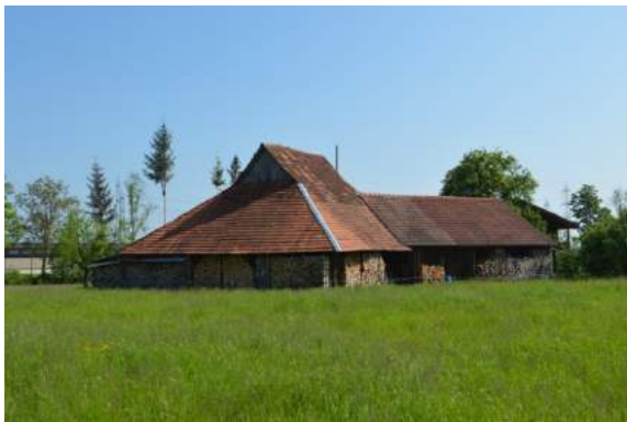
Abb. 127 Speicher Chlewald, Rain, datiert 1698. (Verf. 2023)
