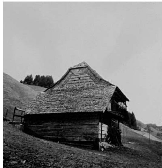
Abb. 92 Speicher Hinter-Längenbach, Luthern. Ansicht von Süden. (Ernst Brunner 1958, in Bauernhausinventar)
