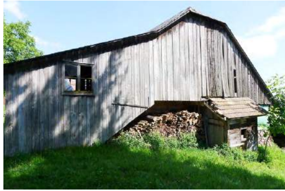
Abb. 86 Rückseite Speicher Mettmenegg, Luthern (Bauinventar, kant. Denkmalpflege Luzern)
