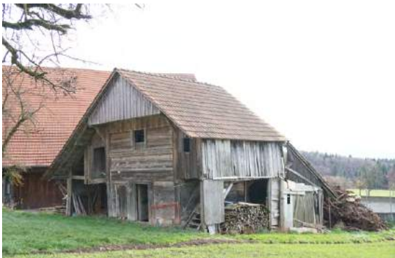
Abb. 135 Speicher Tann, Schenkon, datiert 1701. (Bauinventar, kant. Denkmalpflege Luzern)
