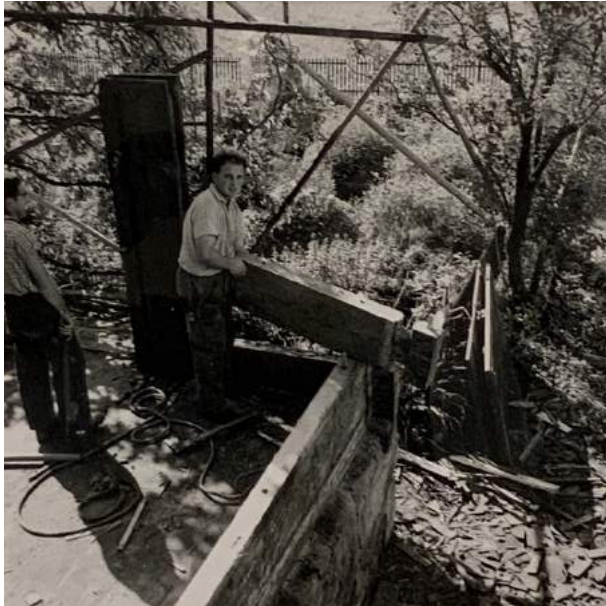
Abb. 101 Abbau des Speichers in der Stechenrain-Mühle, Littau 1961. (Ernst Brunner 1961, aus Bauernhausinventar)
