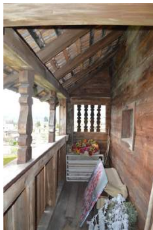
Abb. 29 Laubenraum mit front-seitigem Laubengitter und seitlicher offener Laube am Beispiel des Speichers Schönbühl in Emmen. (Verf. 2023)
