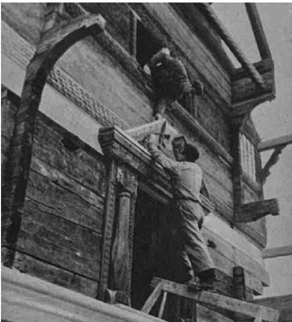
Abb. 157 Speicher Schönbühl, Emmen, Wiederaufbau 1962. (J. K. Felber 1962, in «Der Sonntag» No. 25)
