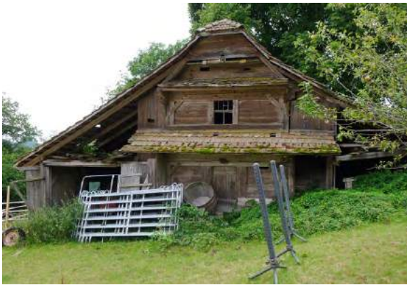
Abb. 113 Speicher Hochbrügg, Luthern, datiert 1733. (Bauinventar kant. Denkmalpflege Luzern)
