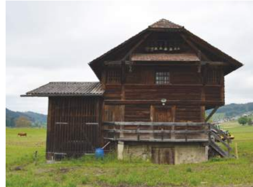
Abb. 14 Zur Hälfte eingetieftes Kellergeschoss am Beispiel des Kornspeichers Bruggmatt in Buchs, datiert 1821. (Verf. 2023)
