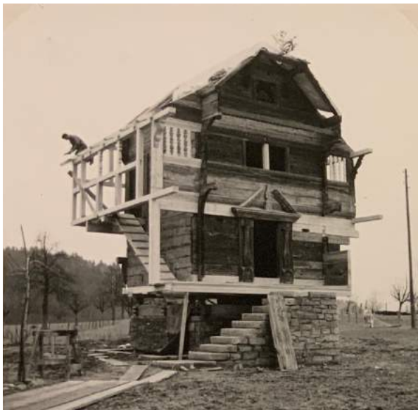
Abb. 24 Rekonstruktionsarbeiten des seitlichen Treppenaufgangs auf die Laube am Speicher Schönbühl in Emmen. (Felber 1962 aus Fotothek kant. Denkmalpflege)
