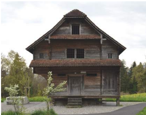
Abb. 147 Speicher Hermolingen, Rothenburg, datiert 1664. Heutiges Erscheinungsbild nach Restaurierung in den 1980er Jahren (Verf. 2023)
