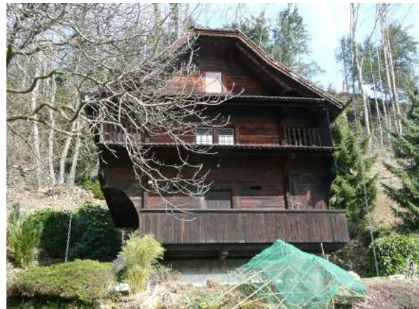
Abb. 62 Frontalansicht Speicher Weggis. (kant. Denkmalpflege Luzern)
