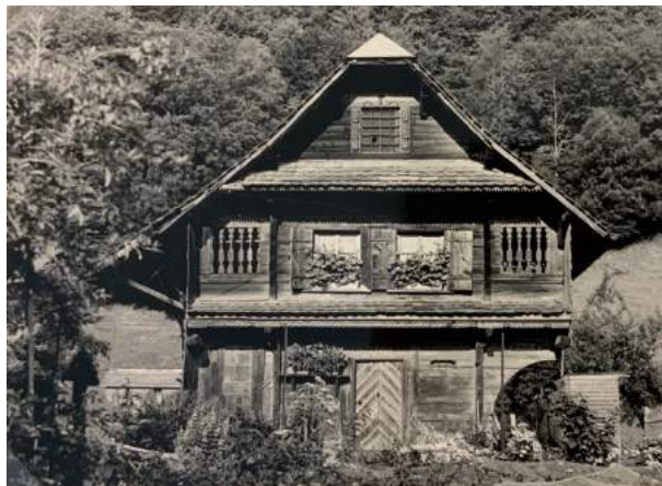
Abb. 142 Speicher Ämserenhof, Werthenstein, Frontalansicht. (U. Büttler 1986, in Fotothek kant. Denkmalpflege Luzern)
