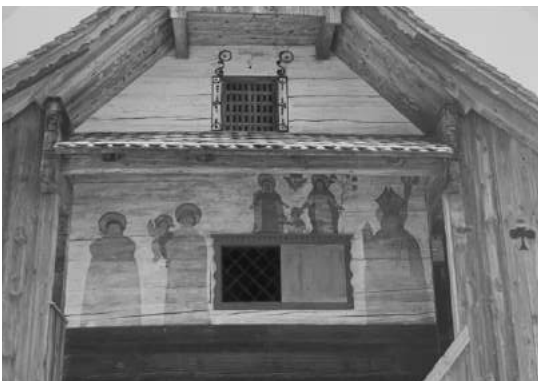
Abb. 51 Speicherbemalung nach Restaurierung des Speicher Werderhof in Michaelskreuz, Root. (A. Huwyler 1983, in Fotothek kant. Denkmalpflege Luzern)
