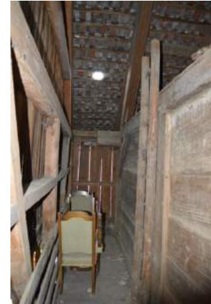
Abb. 35 Aufgang ins DG mit Leiter am Beispiel des Speichers Bruggmatt in Buchs (Verf. 2023)
