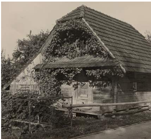
Abb. 105 Speicher Chrisostenhof, Alberswil mit Anbau um 1956. (Hans Marti 1956, in Bauernhausinventar)
